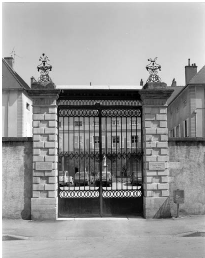
Détail du portail d'entrée, grille fermée.
