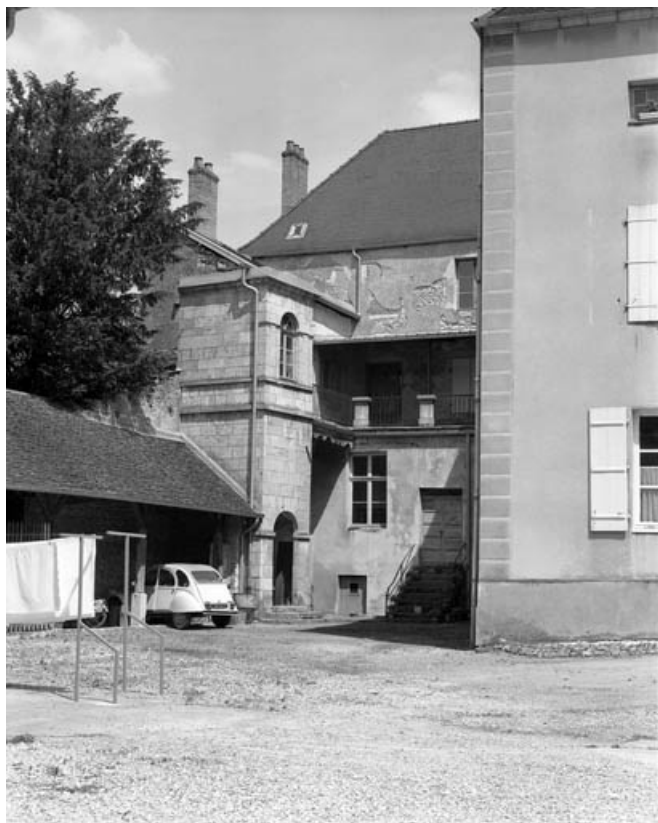
Façade antérieure : détail.
