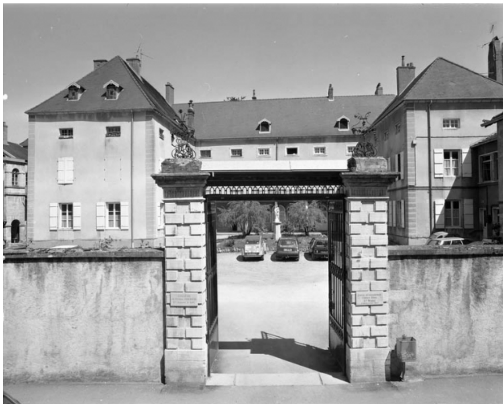
Vue d'ensemble depuis la rue.
