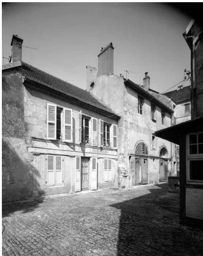
Façades antérieures des remise et logement à droite de la cour (6 rue Victor Hugo). 70, Gray, 5 rue de la Petite Fontaine
