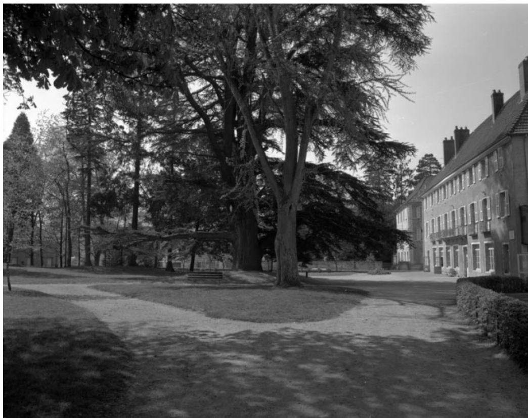
Parc et façade postérieure de la Maison des Associations.
