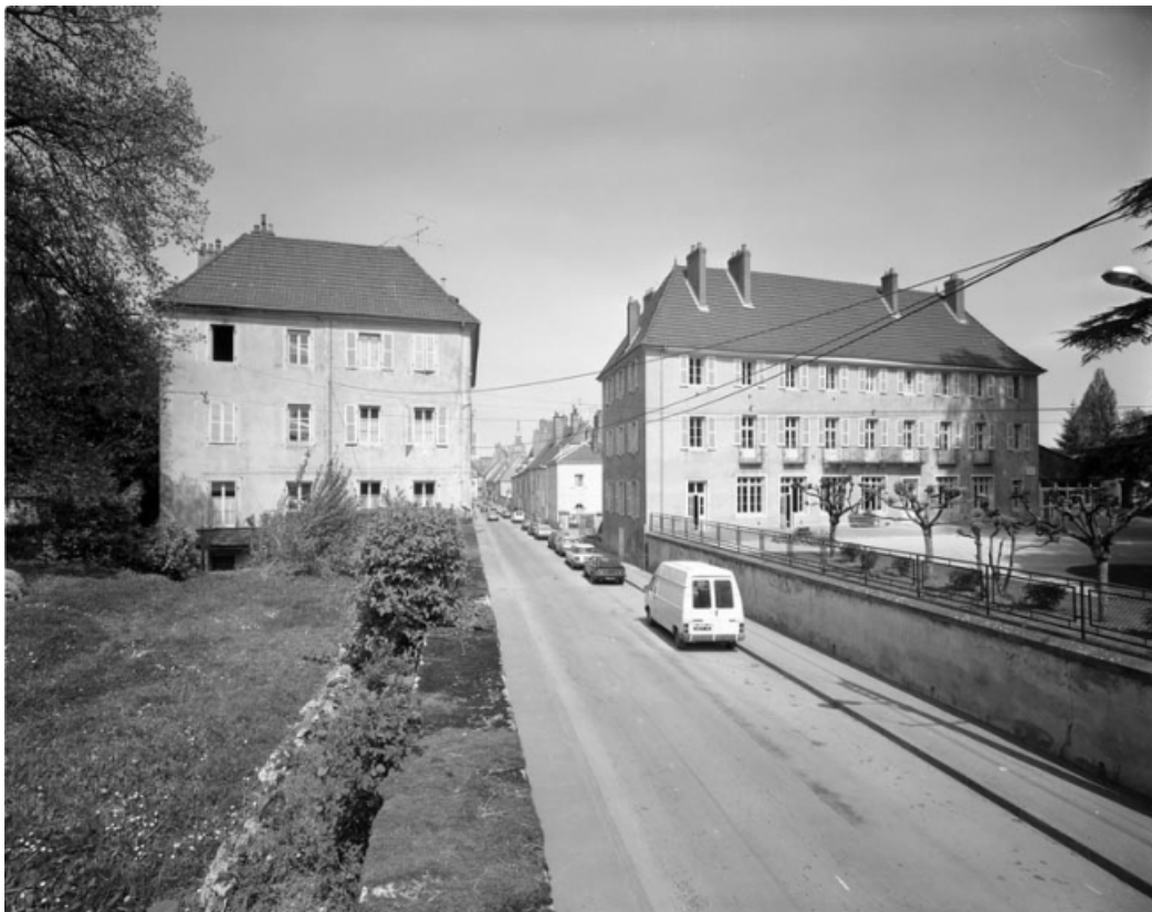
A gauche de la rue : façade antérieure de l'immeuble AY17, à droite : façade sur parc de la Maison des Associations Grayloises. 70, Gray rue Victor Hugo
