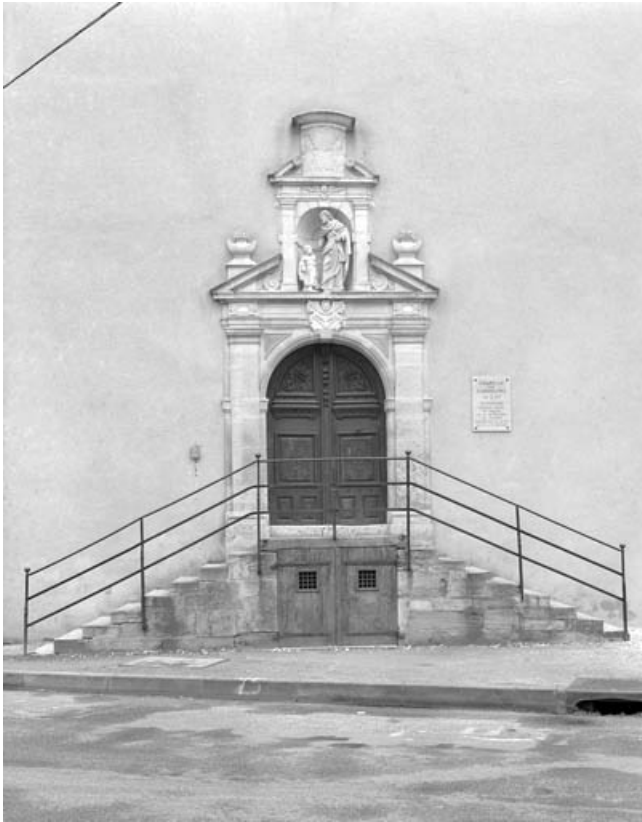
Chapelle : portail d'entrée. 70, Gray rue des Casernes
