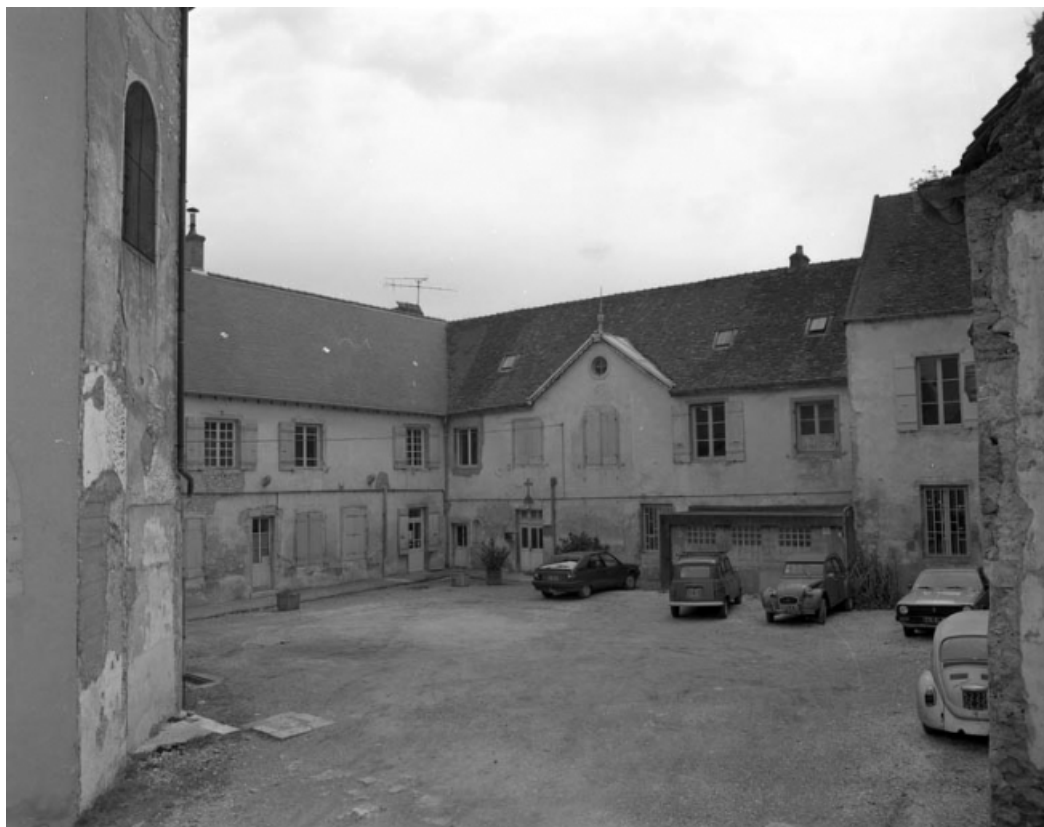
Vue d'ensemble des bâtiments situés dans la cour à l'arrière de la chapelle. 70, Gray rue des Casernes
