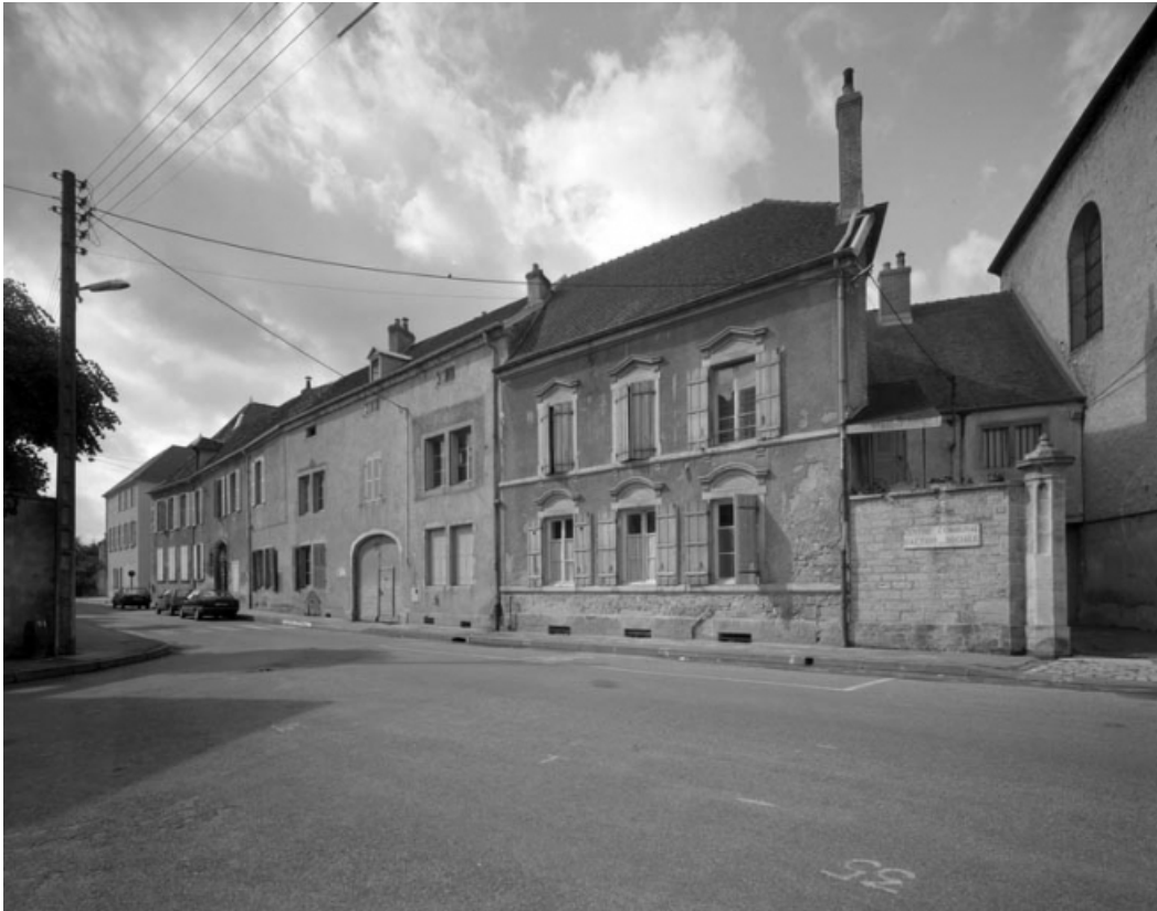
Façade sur rue : partie gauche.
