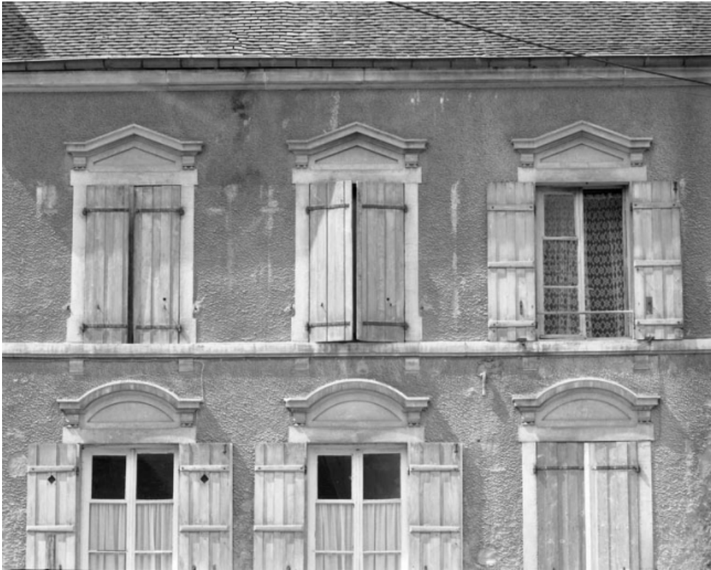
Façade sur rue : détail des baies.
