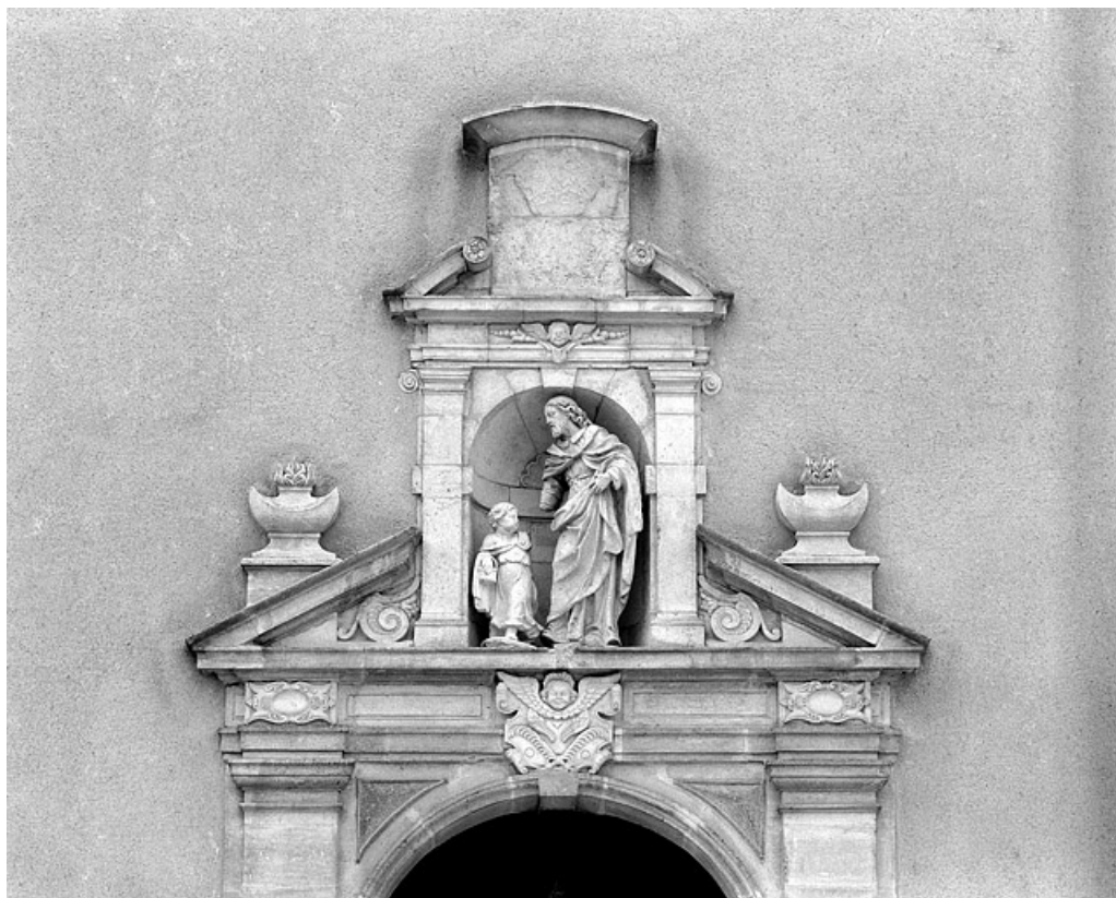
Chapelle : portail d'entrée, détail du fronton. 70, Gray rue des Casernes
