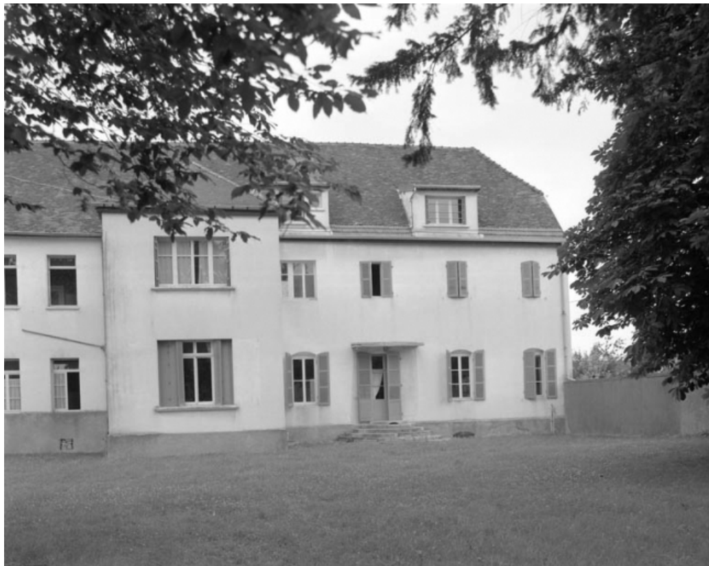
Façade postérieure du bâtiment principal : partie droite.
