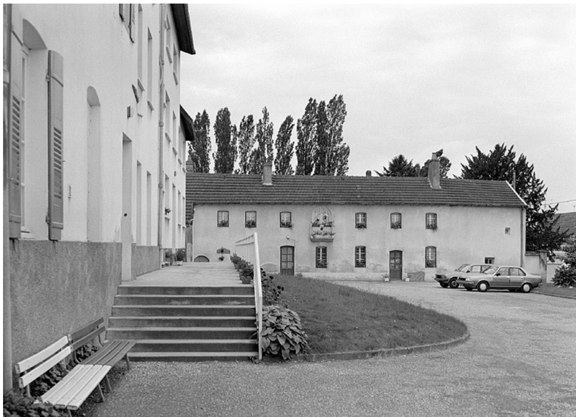
Vue d'ensemble du bâtiment droit.
