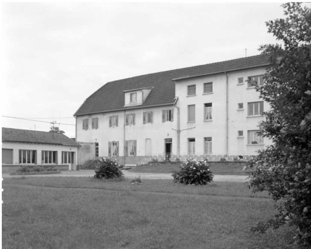
Vue d'ensemble de la façade antérieure du bâtiment principal, de trois quarts droit. 70, Gray avenue des Capucins
