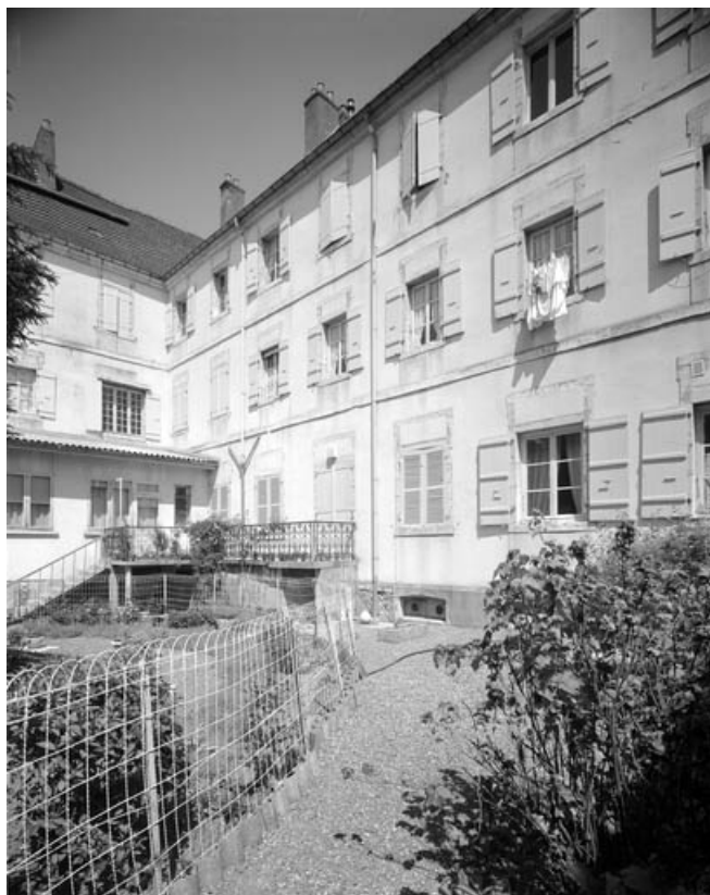
Façade postérieure du bâtiment principal : de trois quarts gauche. 70, Gray place de la Sous-Préfecture
