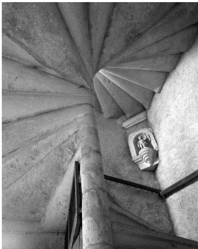
Partie gauche du couvent : détail de l'escalier en vis desservant le bâtiment en fond de cour. 70, Gray place de la Sous-Préfecture
