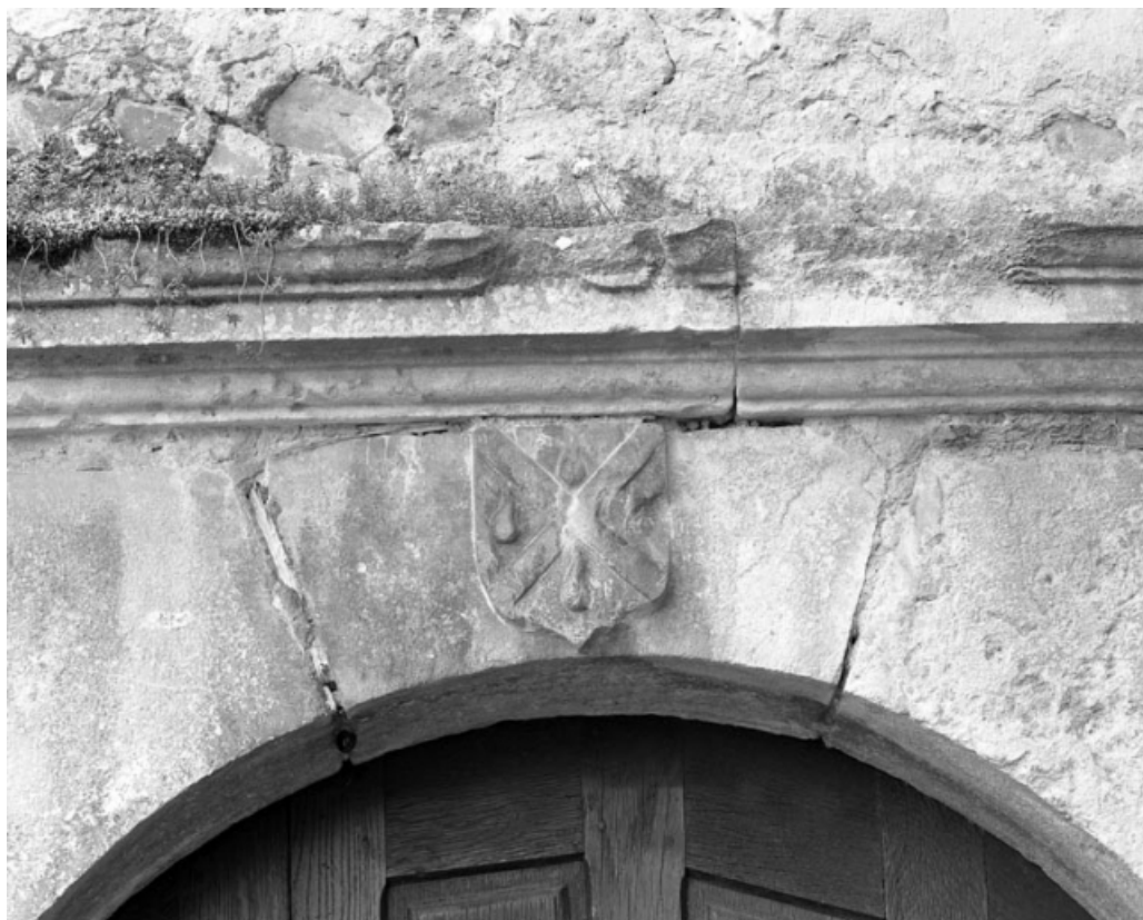
Partie gauche du couvent : détail du blason sur la porte d'entrée de l'escalier du bâtiment en fond de cour. 70, Gray place de la Sous-Préfecture
