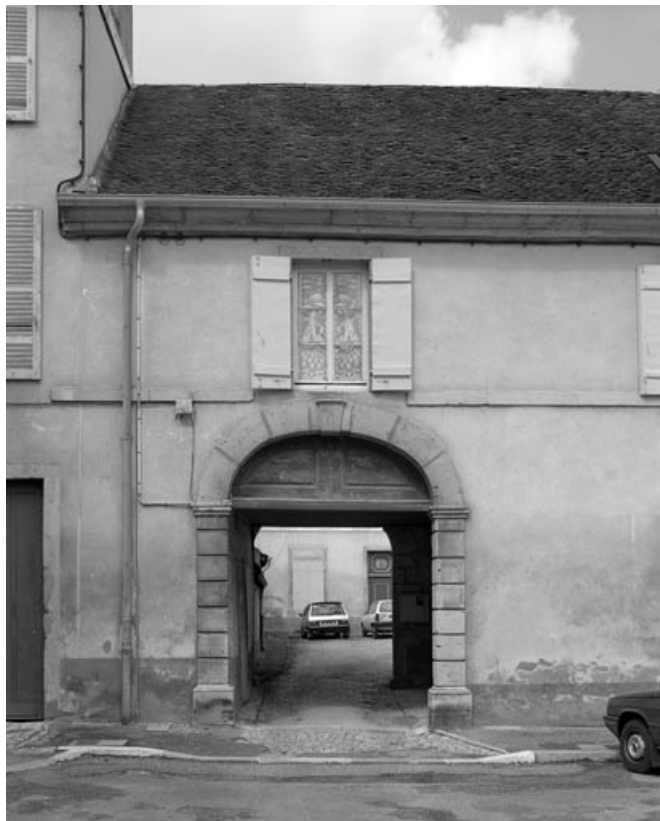
Passage couvert à gauche des bâtiments sur rue, depuis la place. 70, Gray place de la Sous-Préfecture
