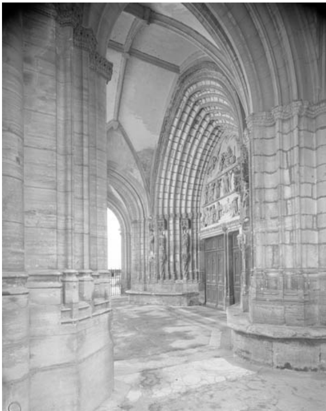
vue de la porte principale, de trois quarts droit depuis le porche.
