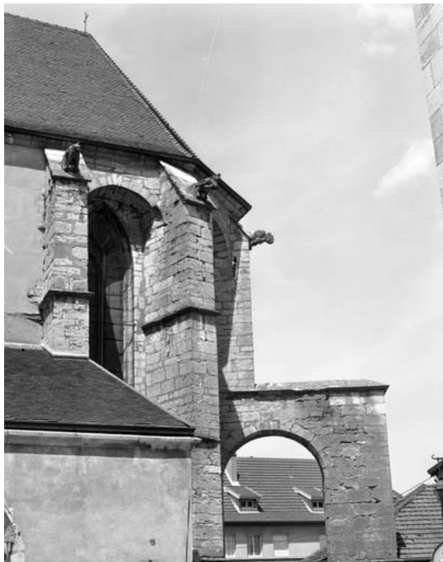
Chevet : détail des contreforts partie droite.
