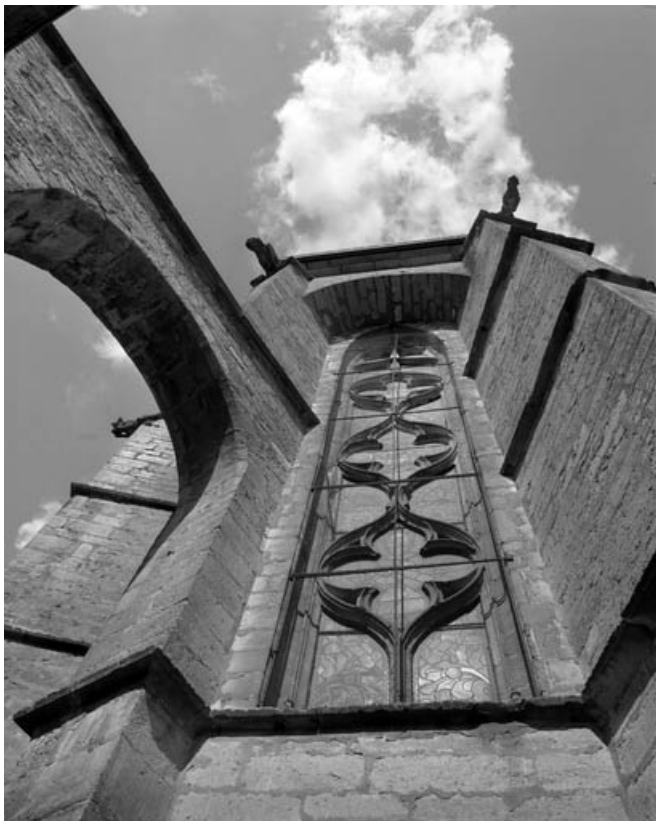
Chevet : détail d'une baie.
