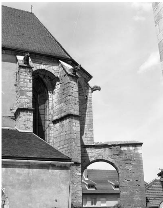
Chevet : détail des contreforts partie droite.
