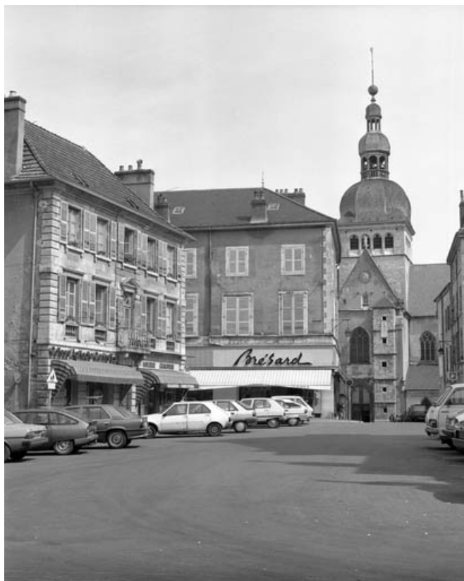
Clocher et bras droit du transept depuis la place Charles de Gaulle. 70, Gray place de la Sous-Préfecture
