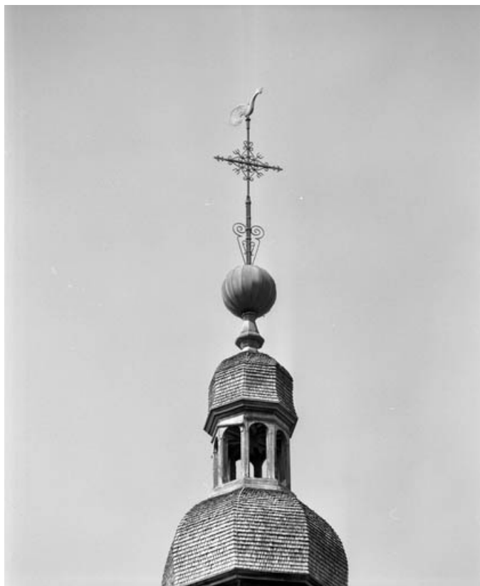
Tour-clocher : détail du lanternon.
