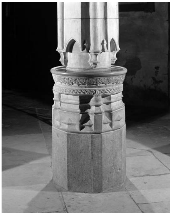
Intérieur : détail de la base d'une colonne de la première travée de la nef formant un bénitier. 70, Gray place de la Sous-Préfecture
