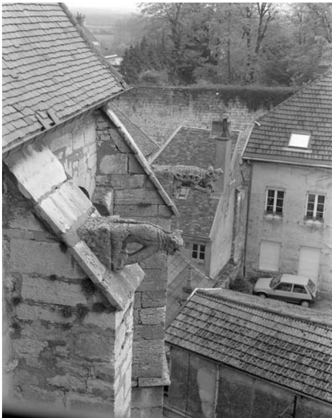
Détail des gargouilles sur les contreforts du choeur.
