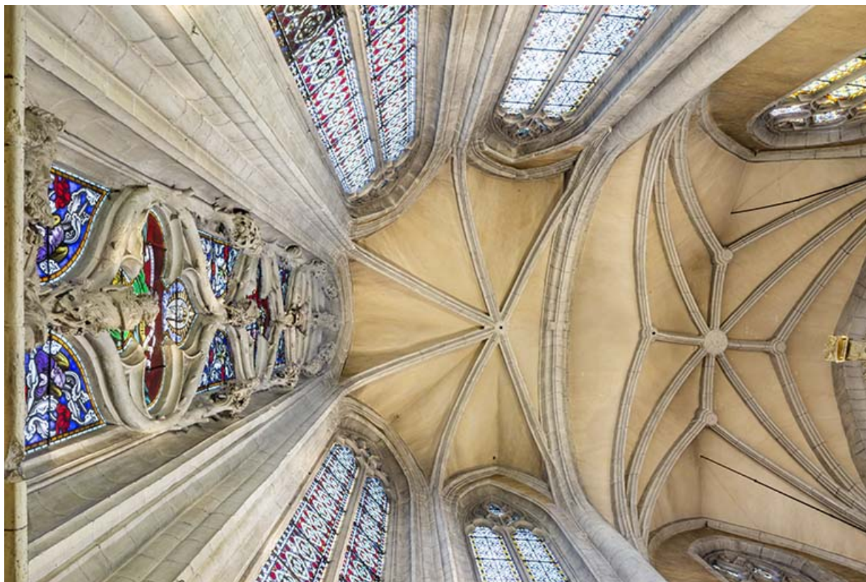
Voûte et abside du chœur en 2022.
