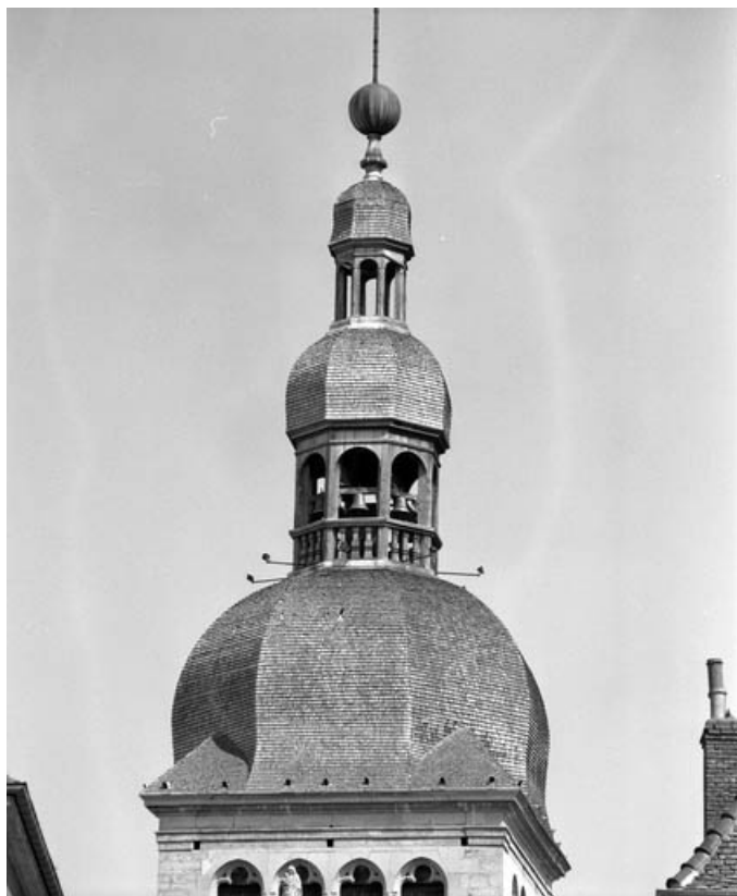
Tour-clocher : détail du bulbe et du lanternon.
