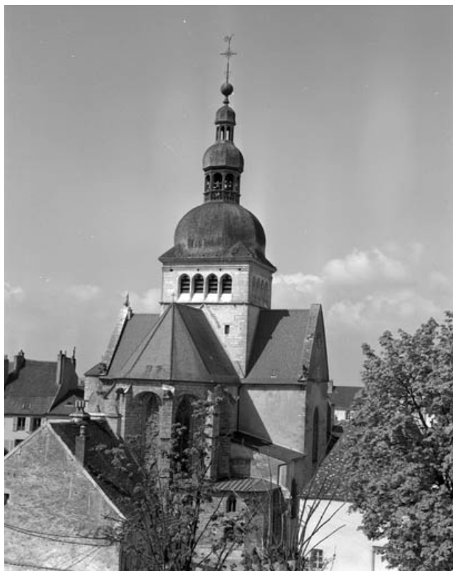
Vue rapprochée du chevet depuis le sommet de la tour du Parais.
