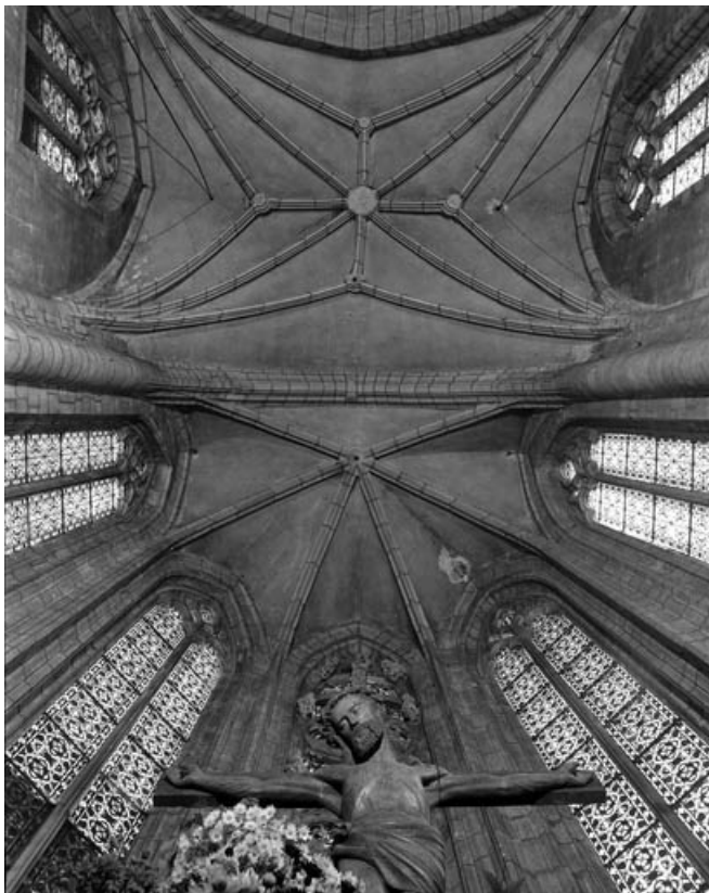
Intérieur : vue des voûtes de l'abside et du chœur.
