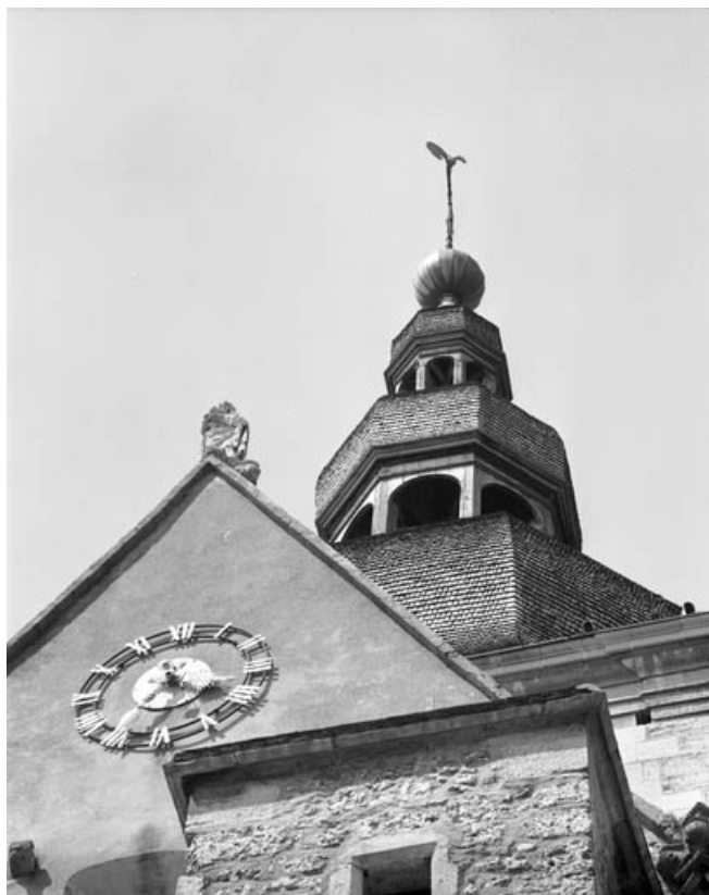
Pignon du bras droit du transept et flèche polygonale du clocher. 70, Gray place de la Sous-Préfecture
