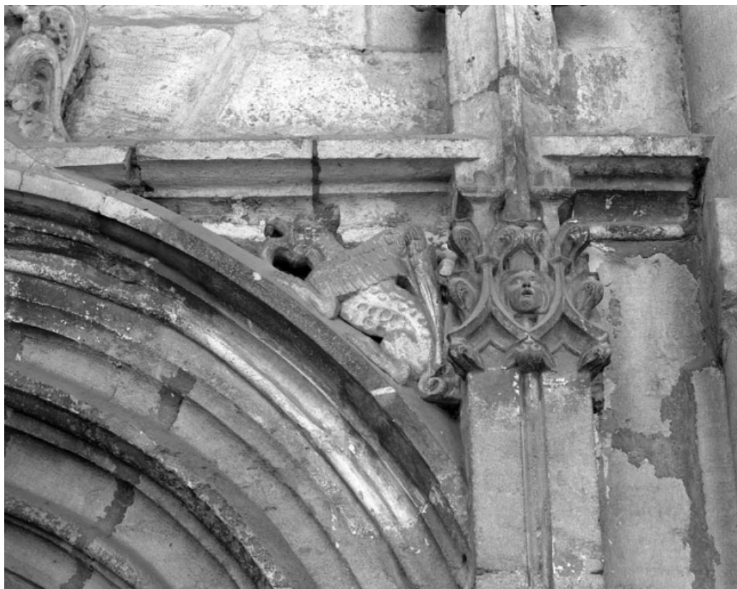
Façade antérieure, portail : détail de l'écoignon figuré droit de la porte d'entrée droite. 70, Gray place de la Sous-Préfecture
