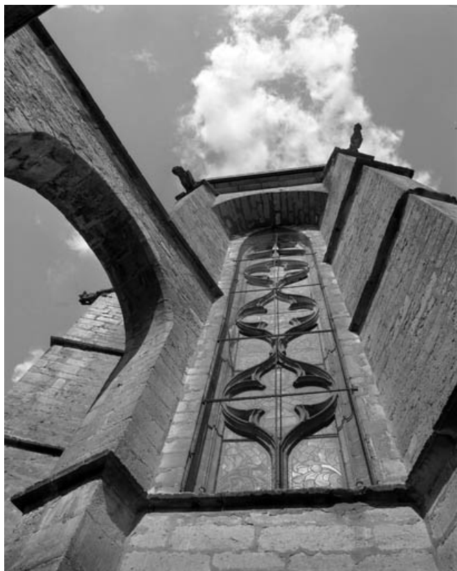
Chevet : détail d'une baie.
