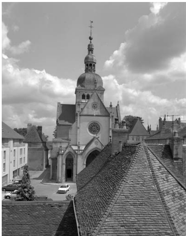
Vue de la façade antérieure depuis l'ancien couvent des Annonciades. 70, Gray place de la Sous-Préfecture
