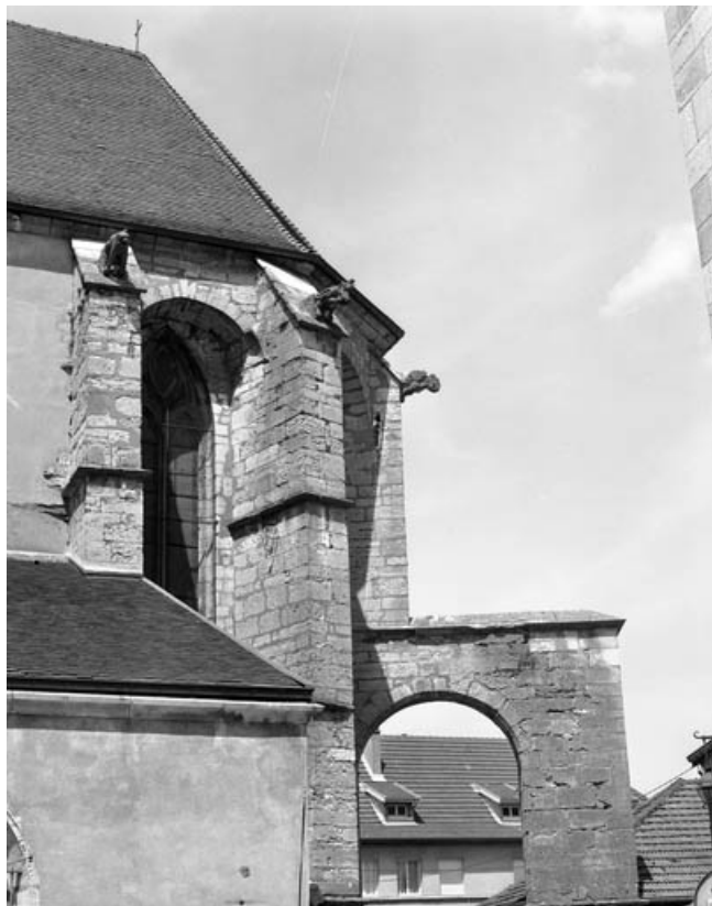
Chevet : détail des contreforts partie droite.
