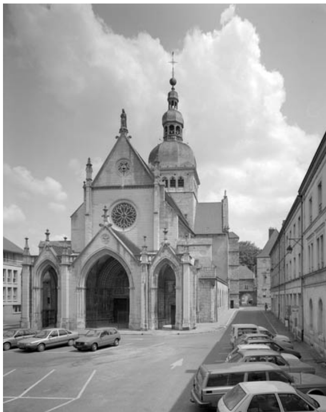
Vue d'ensemble de la façade antérieure.
