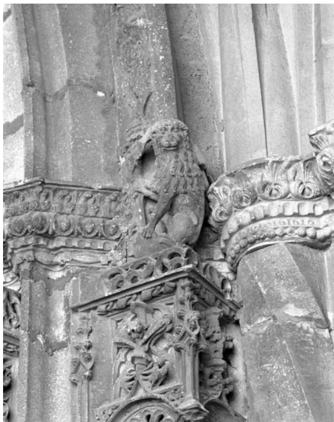
Façade antérieure, portail : porte centrale, détail du départ droit du premier rouleau de la voussure. 70, Gray place de la Sous-Préfecture
