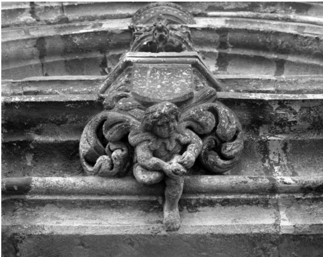
Façade antérieure, portail : détail de la sculpture au centre du linteau de la porte d'entrée droite. 70, Gray place de la Sous-Préfecture
