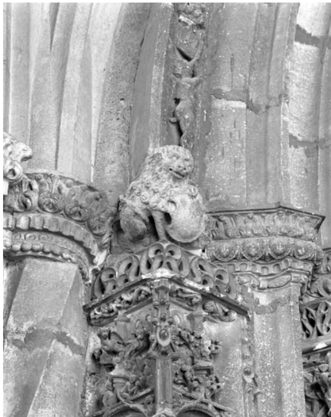
Façade antérieure, portail : porte centrale, détail du départ gauche du premier rouleau de la voussure. 70, Gray place de la Sous-Préfecture
