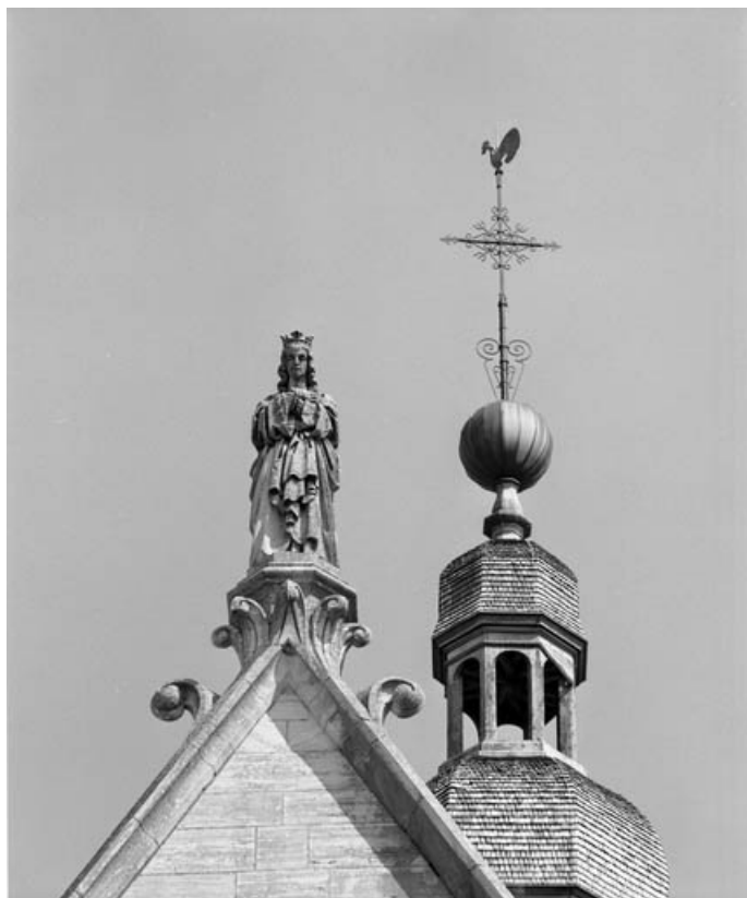
Bras du transept : détail de la statue au sommet du pignon.
