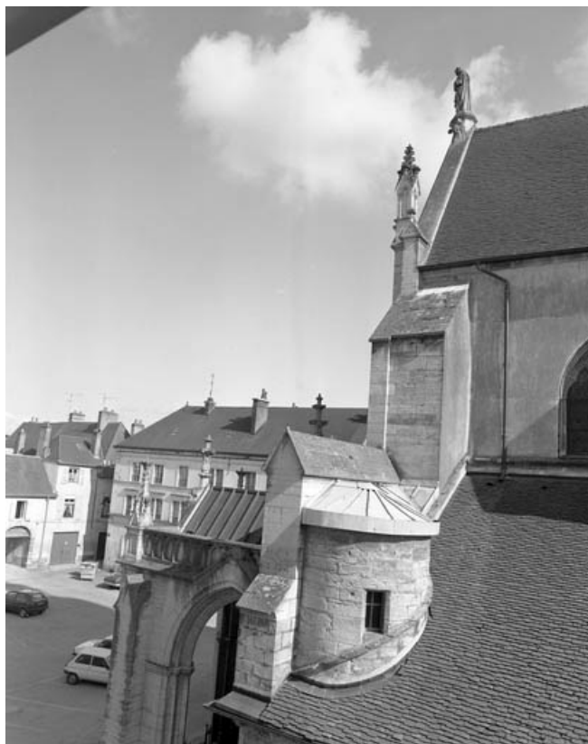
Façade occidentale : contreforts et tourselle d'escalier au nord-ouest. 70, Gray place de la Sous-Préfecture
