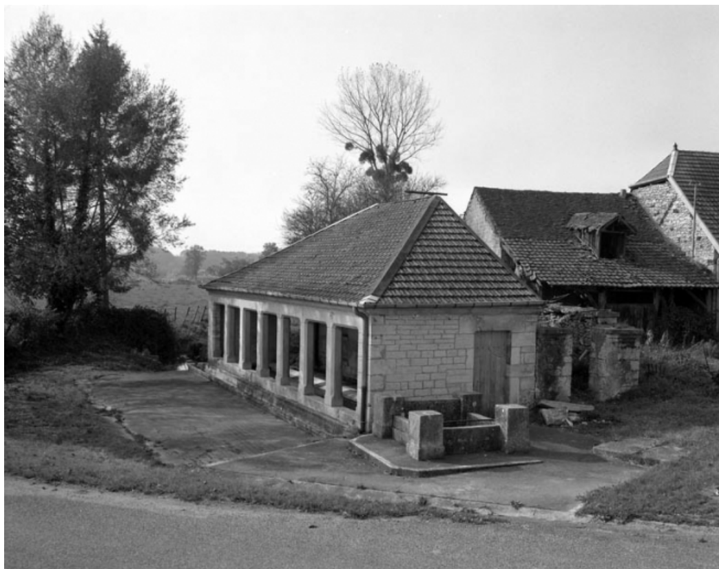
Façades postérieures depuis la cour en 1988.
