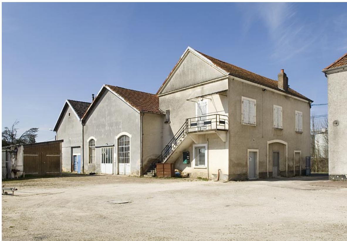
Bâtiments industriels. Atelier et entrepôt depuis la cour.
