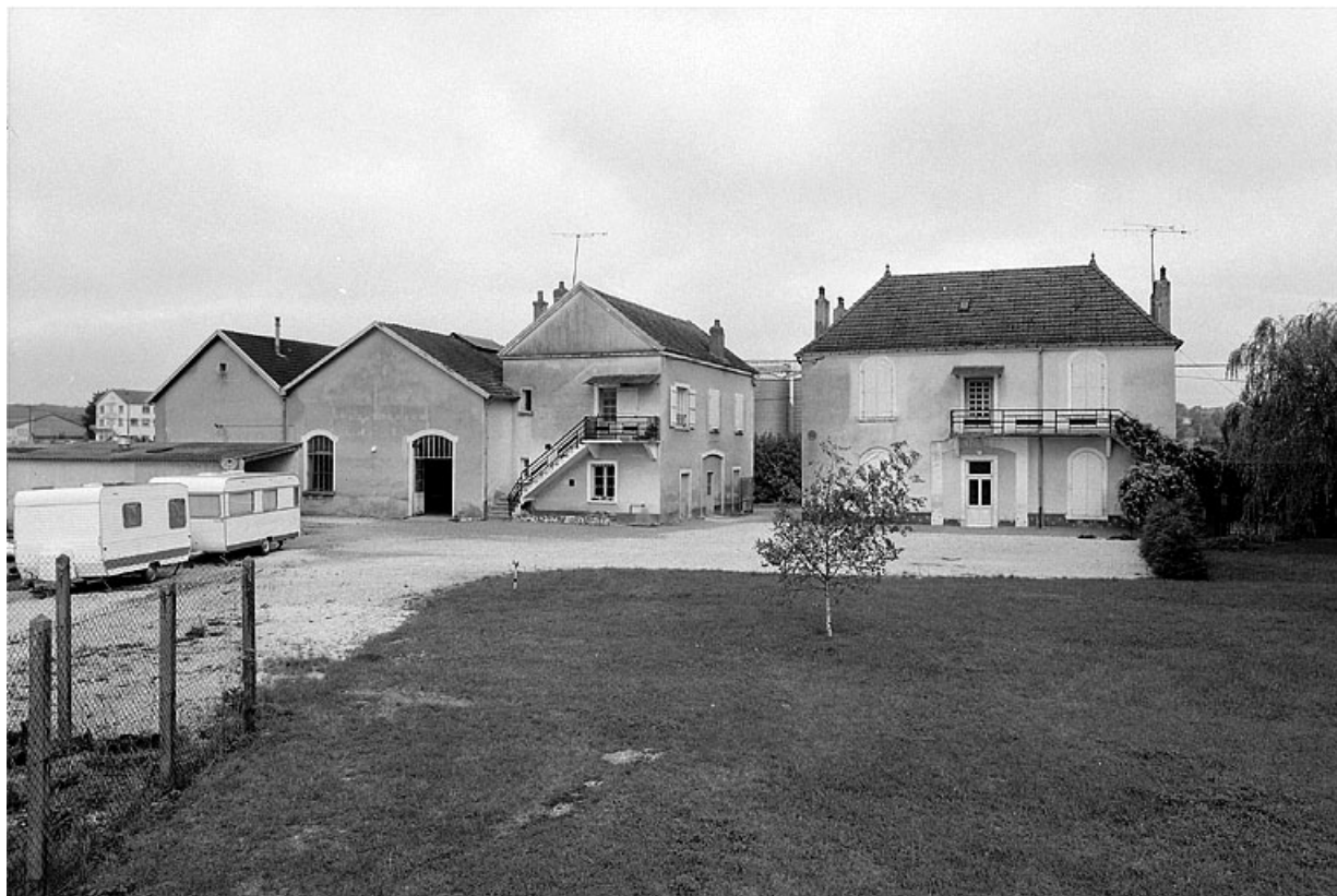
L'usine à gaz : façades postérieures.
