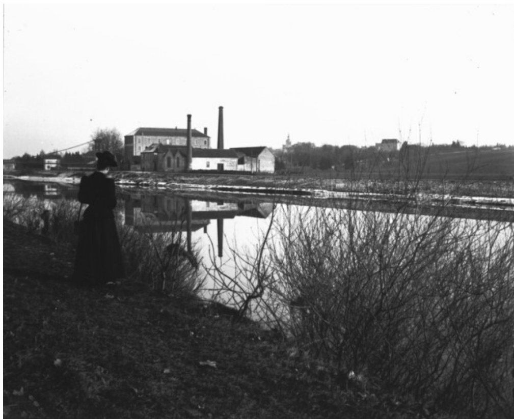
L'usine à gaz depuis la rive droite de la Saône.
