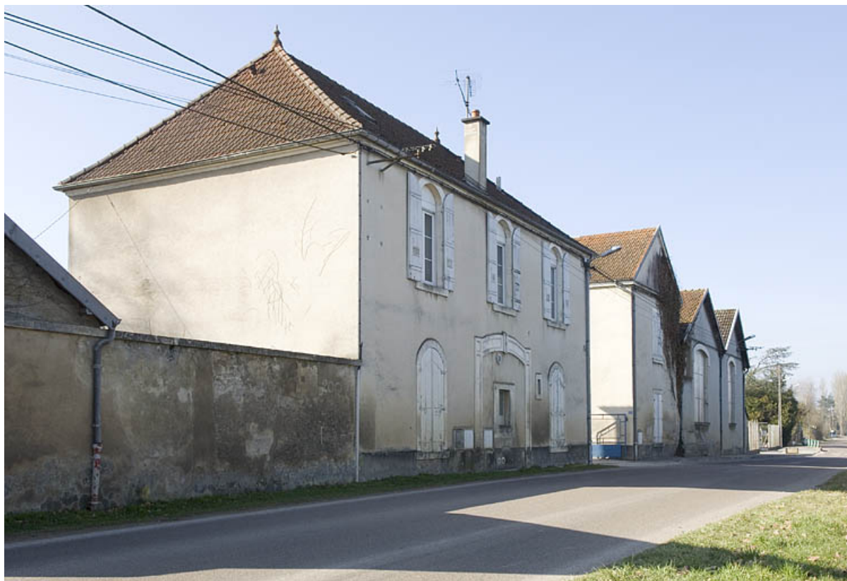
Vue d'ensemble depuis le quai Mavia.
