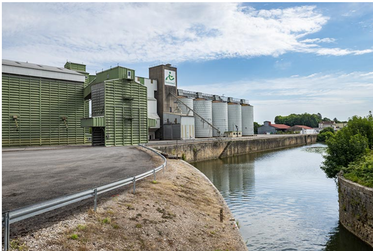
La gare fluviale et les silos depuis l'ouest, vue actuelle. 70, Gray
