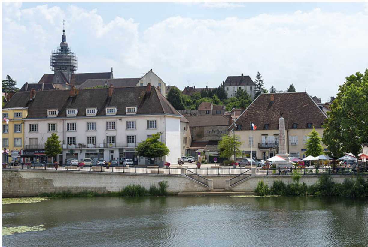
Le quai Saint-Esprit.
