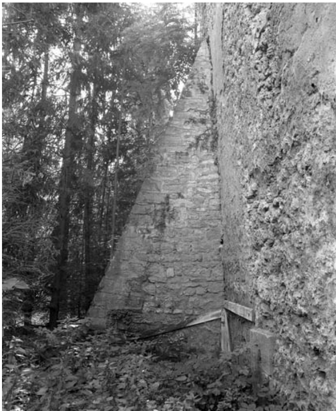
Restes de rempart du bastion de la Visitation (derrière la rue Cécile) : détail d'un contrefort. 70, Gray
