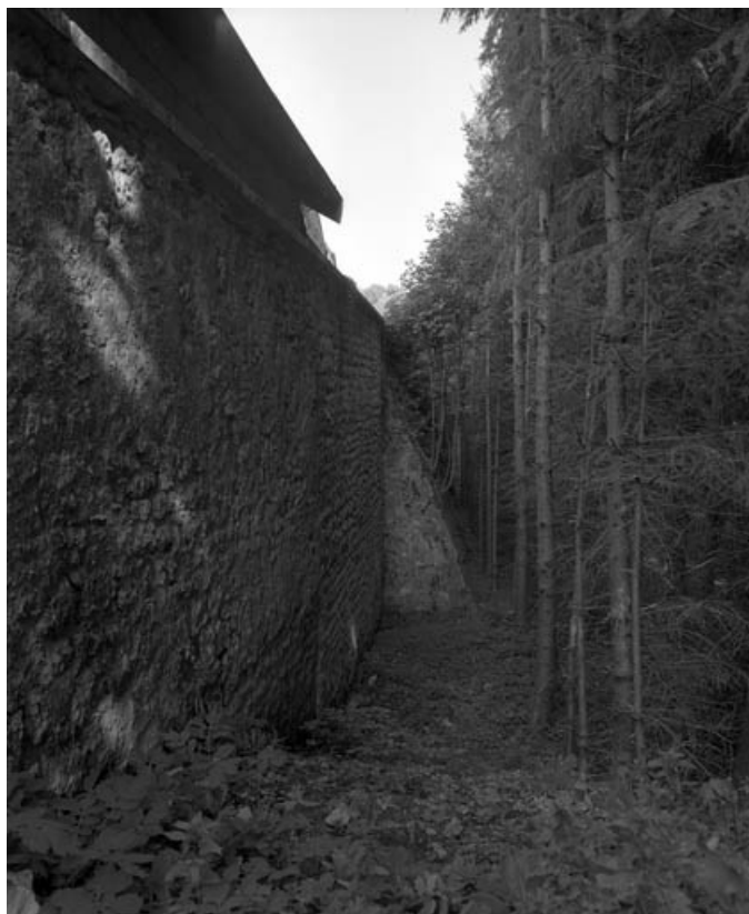
Restes de rempart du bastion de la Visitation (derrière la rue Cécile) : de trois quarts gauche. 70, Gray
