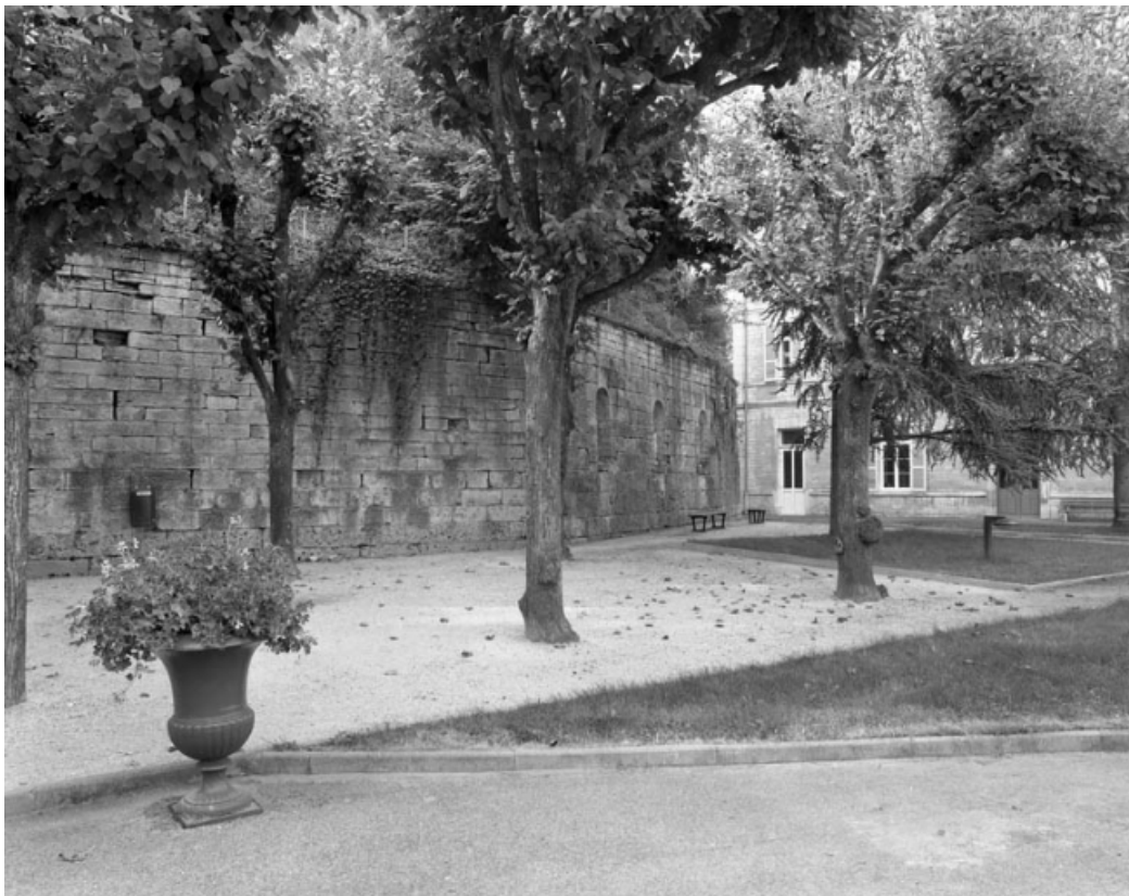
Restes du rempart du bastion du Boulevard dans la cour de l'hotel-dieu : partie inférieure de trois quarts gauche. 70, Gray
