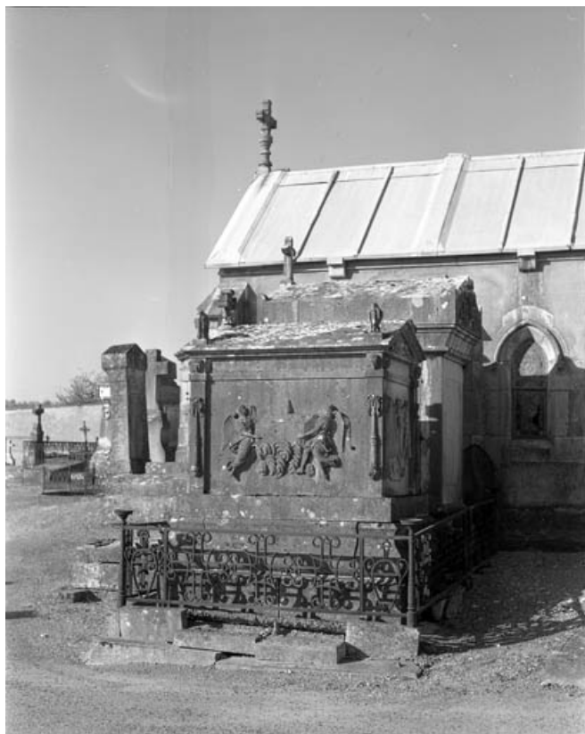
Façade latérale gauche.
