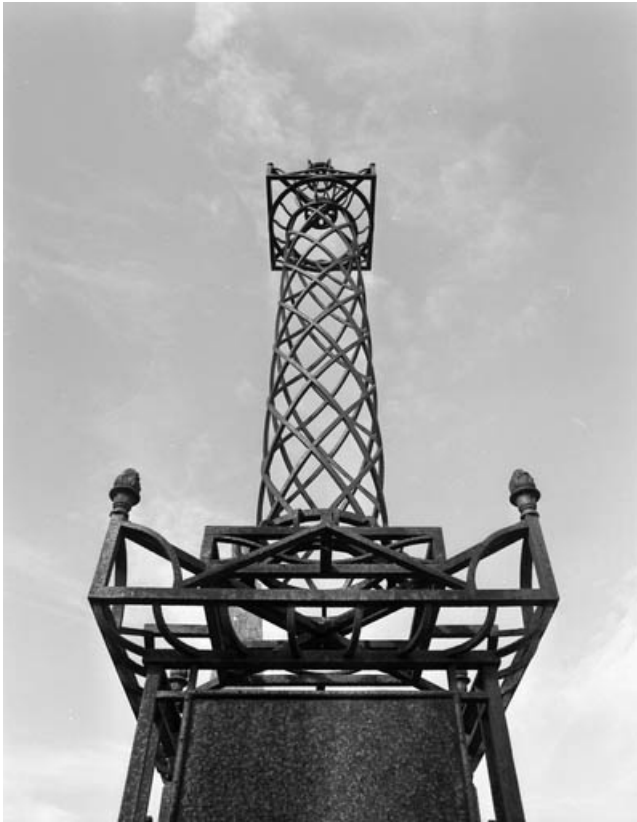
Détail de la colonne en contre-plongée.
