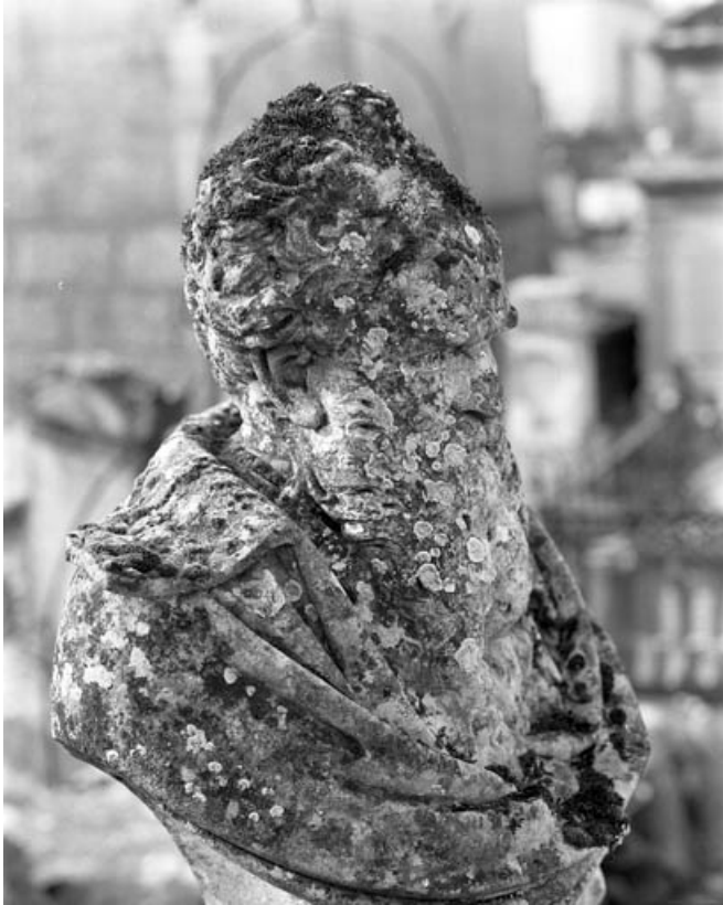
Détail de l'altération de la pierre sur le buste.
