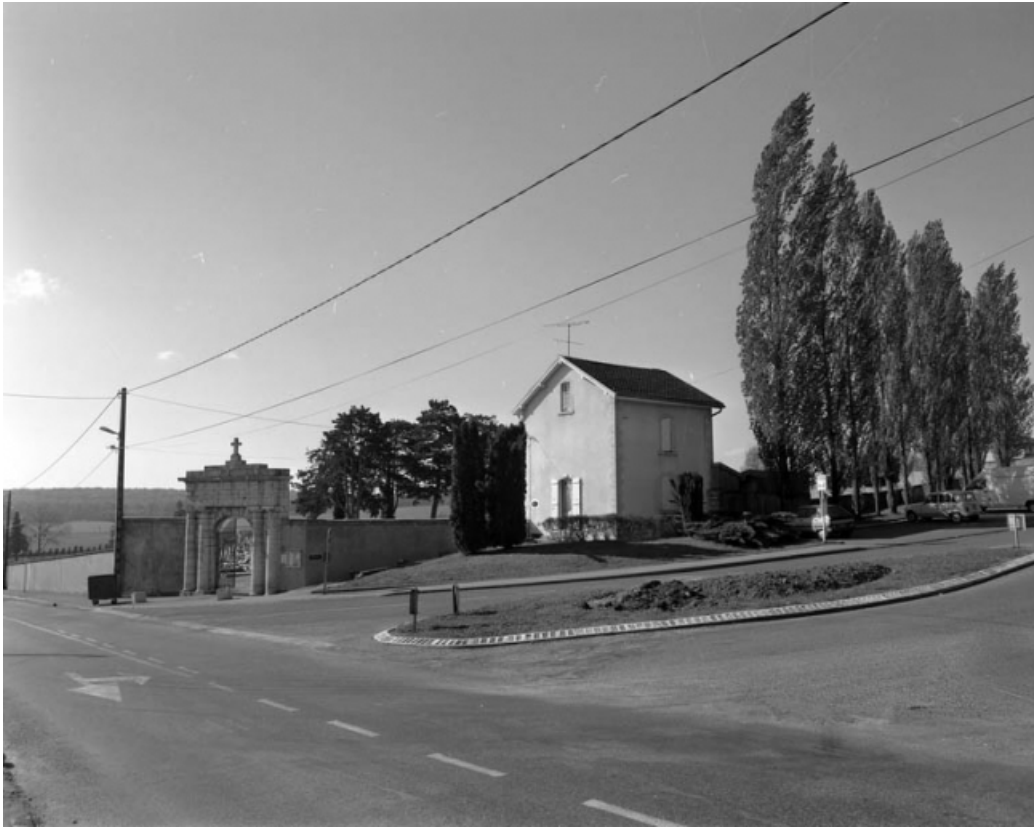
Vue de la maison du gardien et du portail d'entrée, depuis la rue. 70, Gray
