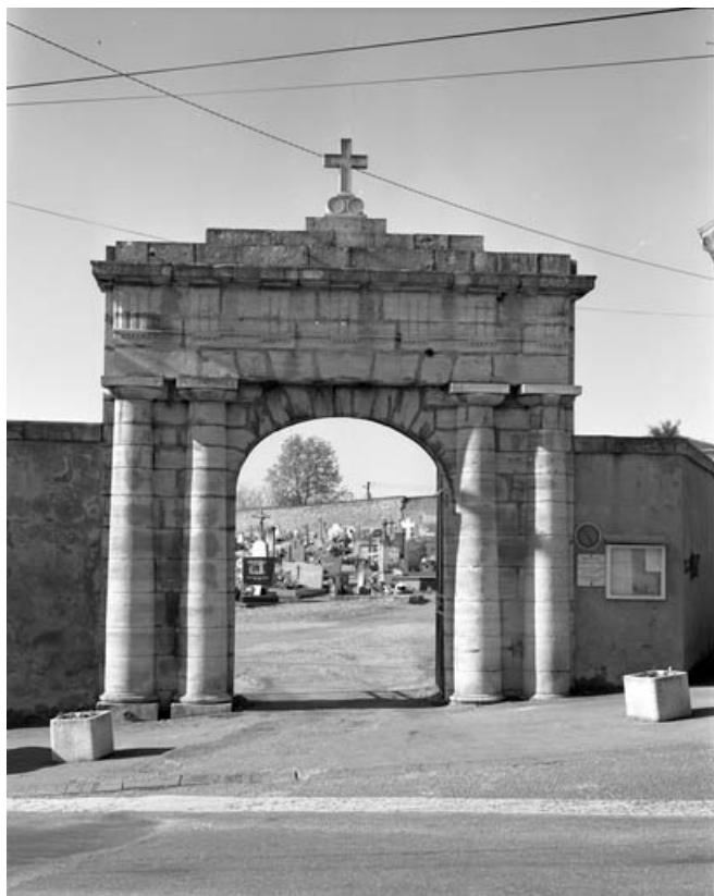
Vue du portail d'entrée : de face.
