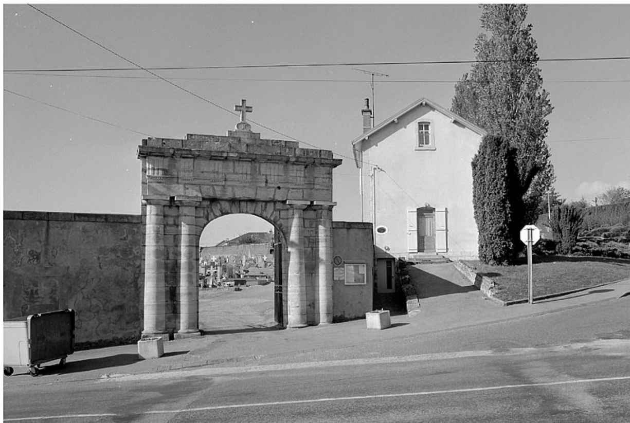
Vue rapprochée du portail d'entrée et de la maison du gardien.
