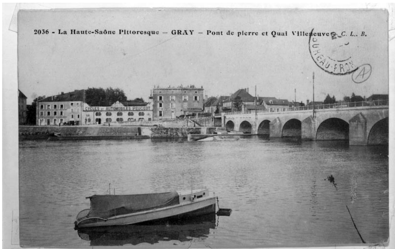
Gray.- Pont de pierre et quai Villeneuve.
