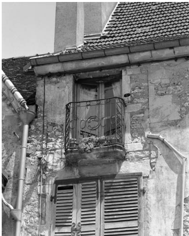
Place de la Petite Fontaine : détail du balcon d'un des édifices formant le fond de la place. 70, Gray
