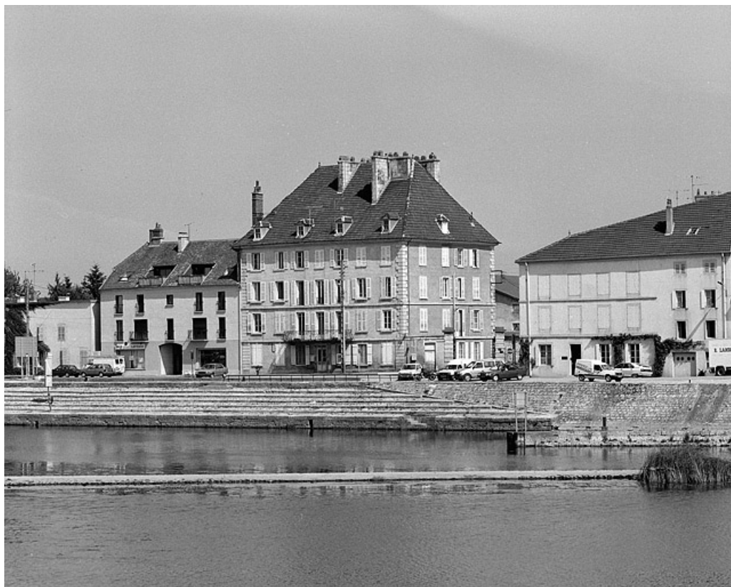
Vue d'ensemble depuis le pont.
