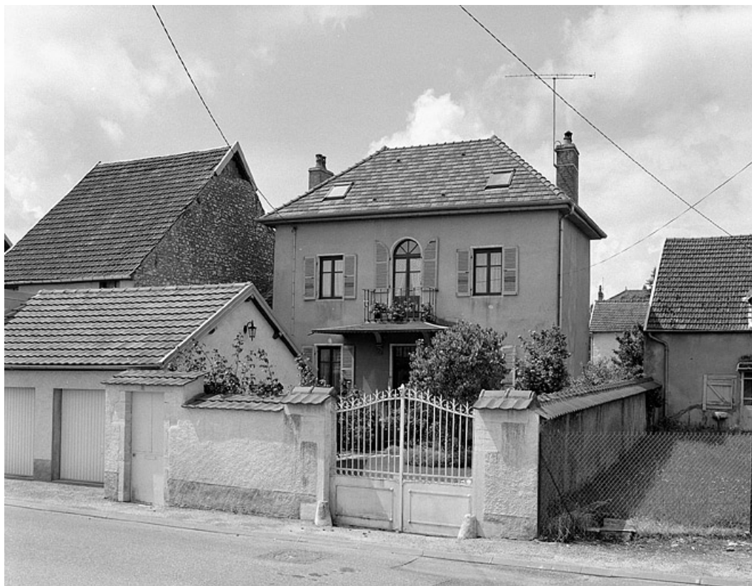
Vue d'ensemble depuis la rue. 70, Gray
