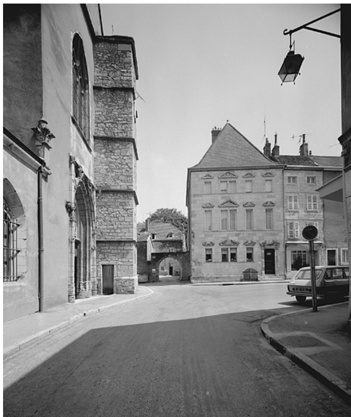
Vue d'ensemble depuis la ruelle de l'Eglise.
