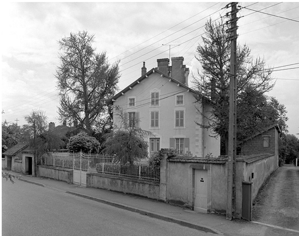
Vue d'ensemble depuis la rue. 70, Gray
