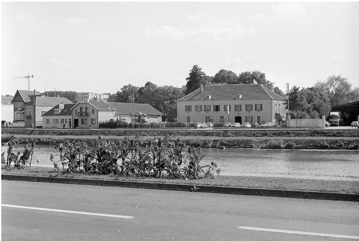
Vue d'ensemble depuis le quai Villeneuve. 70, Gray
