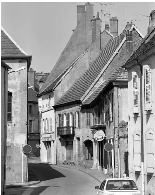
Vue d'ensemble éloignée de la façade sur rue. 70, Gray
