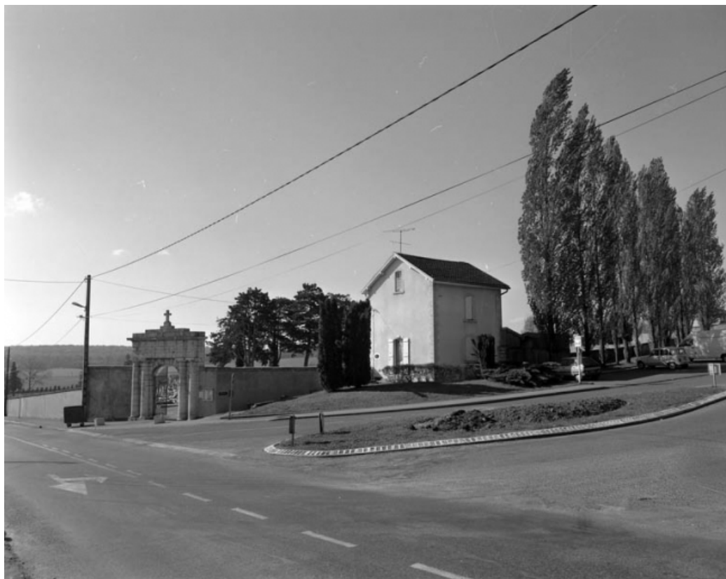
Vue de la maison du gardien et du portail d'entrée, depuis la rue. 70, Gray
