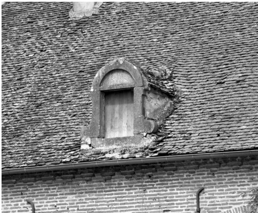
Logis, détail d'une lucarne.
