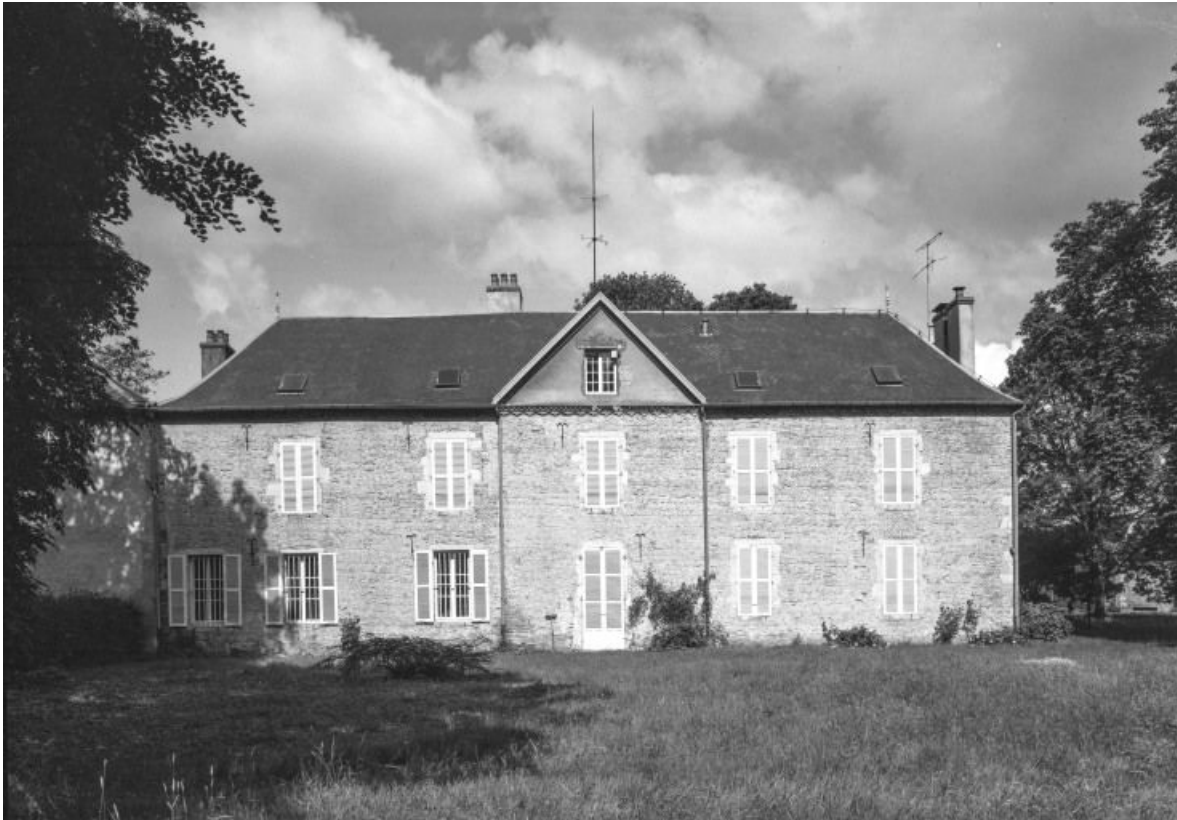
Corps d'habitation, élévation postérieure.
