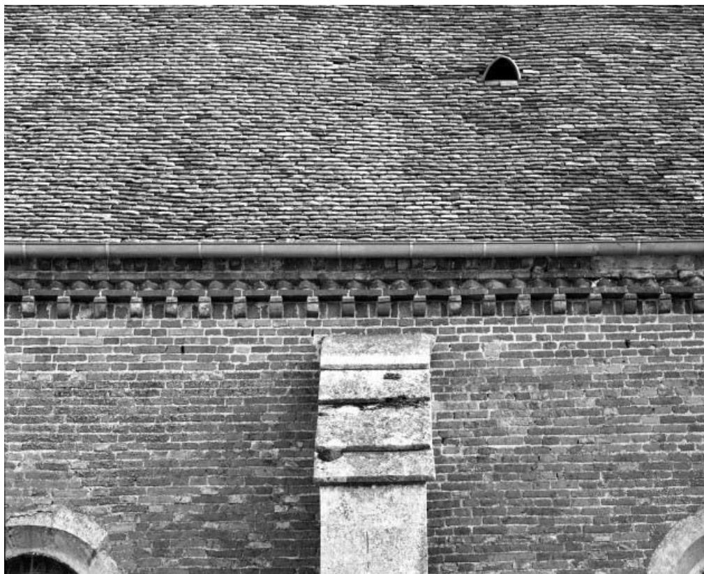
Élévation gauche, chœur, détail de la corniche 21, Tichey
