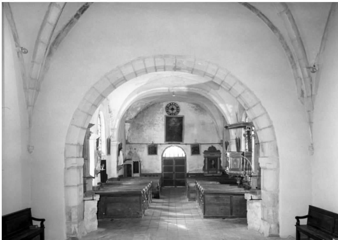
Vue intérieure prise du choeur
