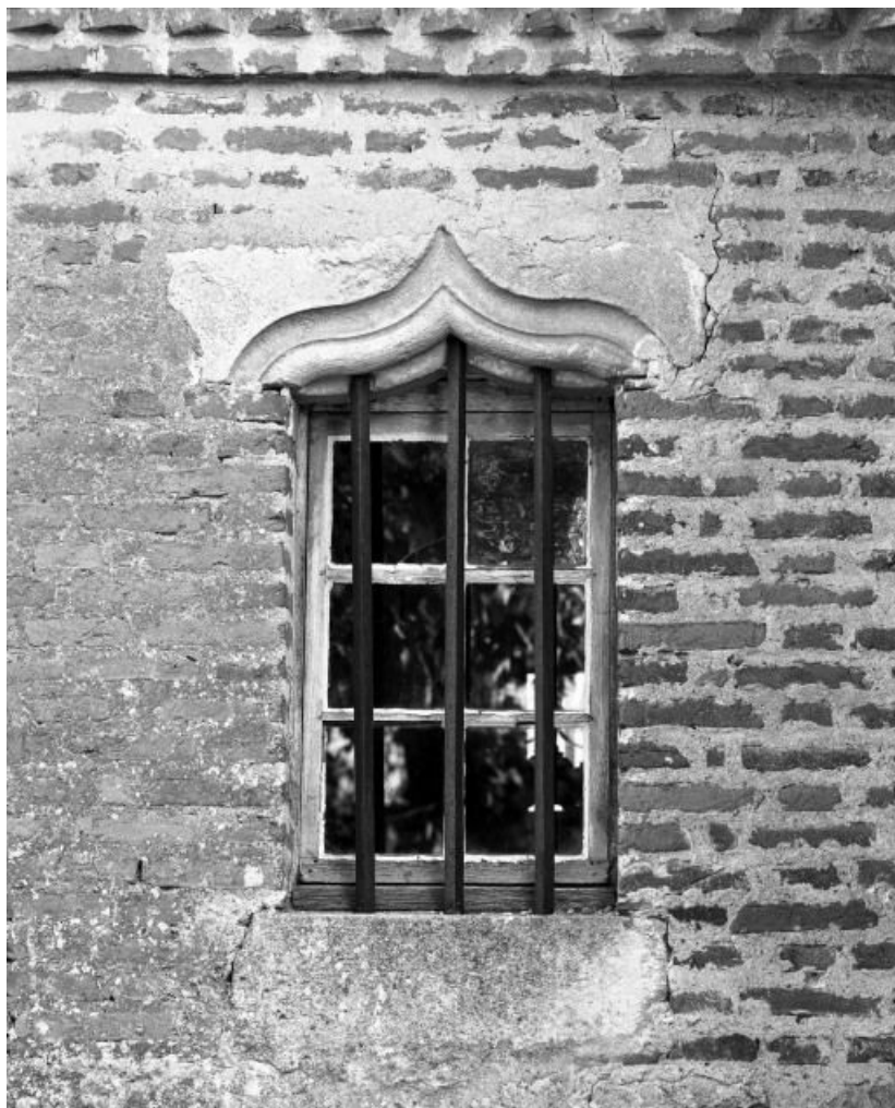
Sacristie, fenêtre du mur droit 21, Tichey
