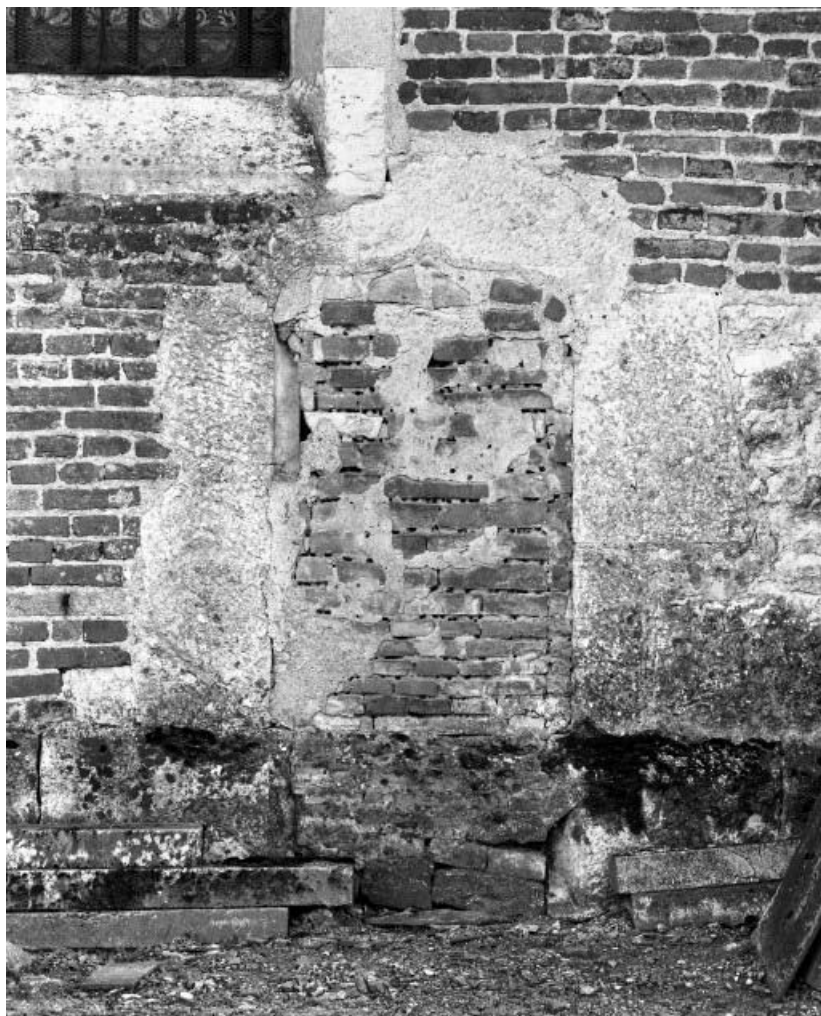
Élévation gauche, porte murée
