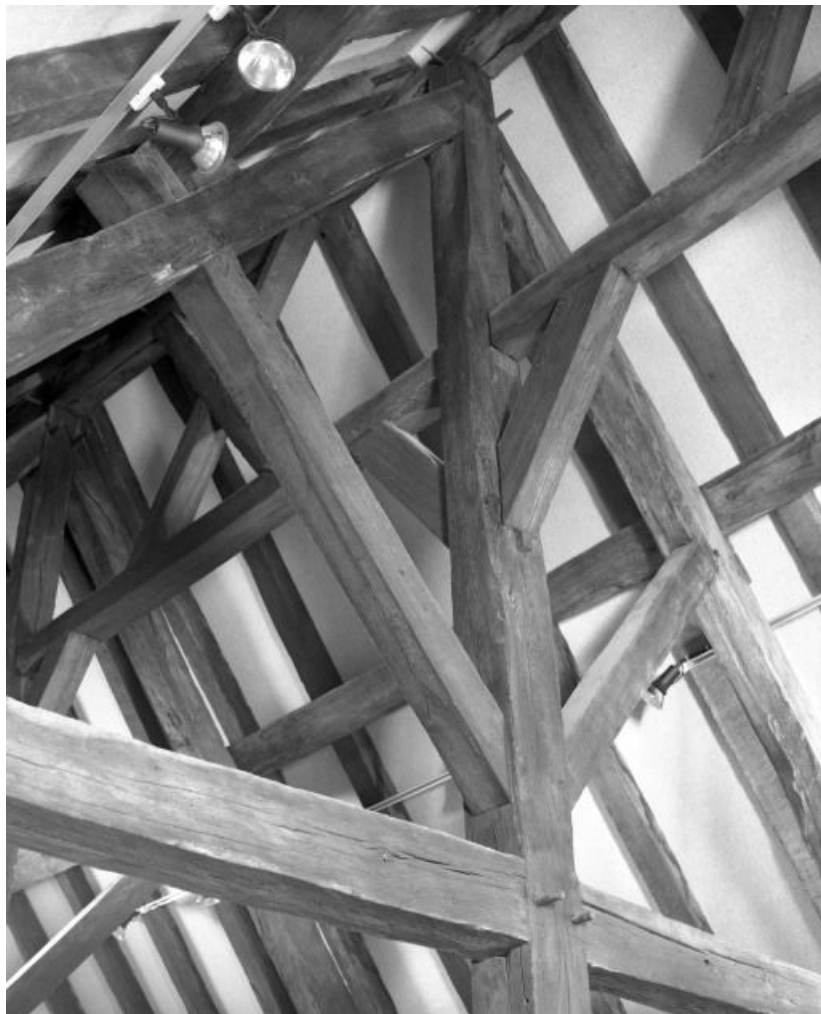
Charpente du niveau supérieur du comble.
