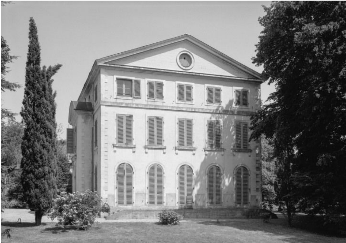
Pavillon ouest, élévation ouest.
