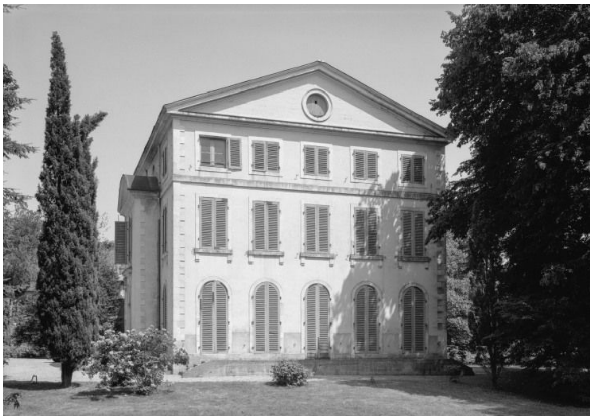
Pavillon ouest, élévation ouest.
