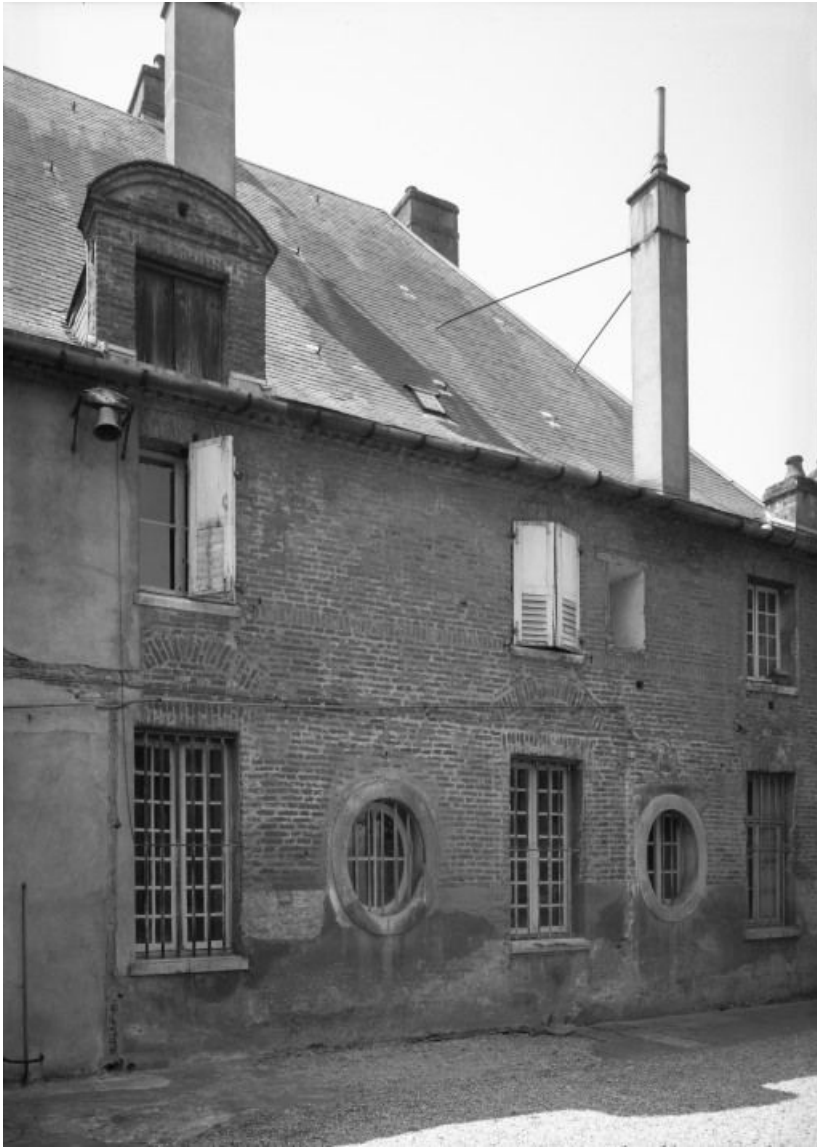
Mur postérieur du corps de logis.
