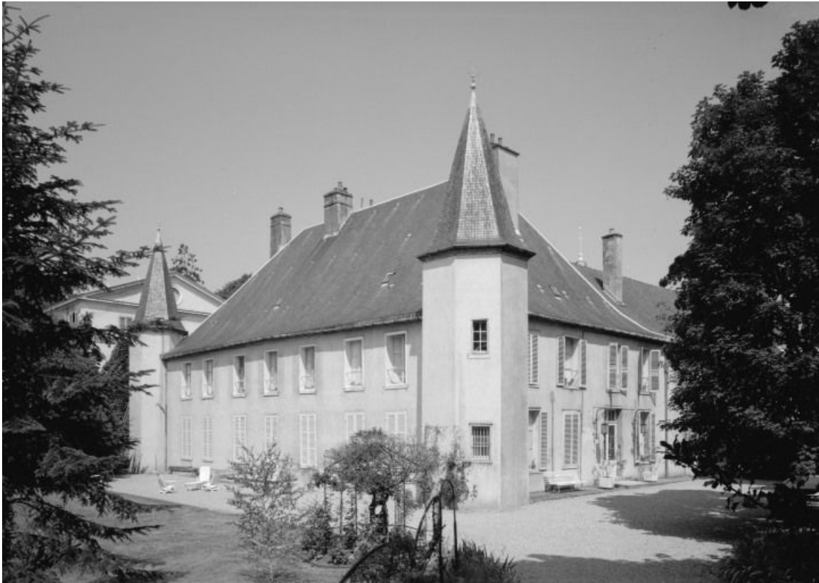
Corps de logis principal. 21, Seurre rue du Château
