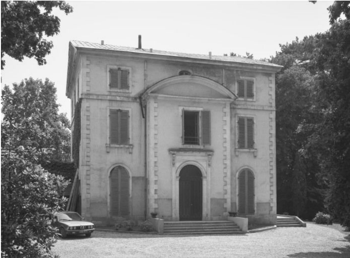
Pavillon ouest, façade antérieure.
