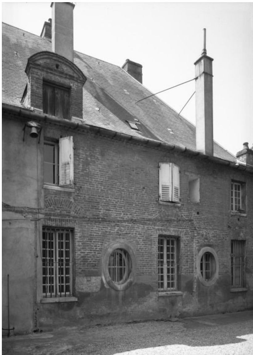
Mur postérieur du corps de logis.
