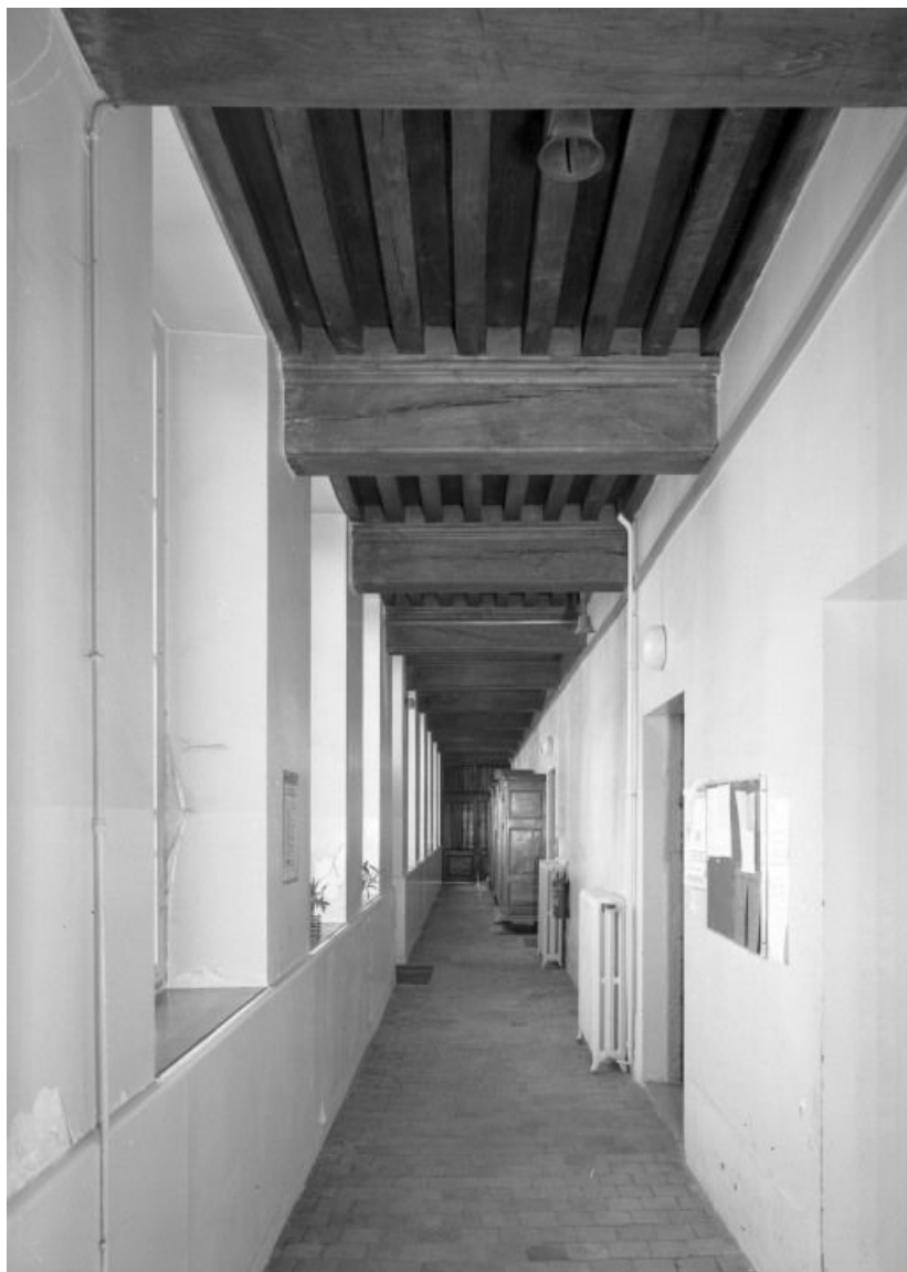
Aile gauche, couloir du rez-de-chaussée, vue prise de l'entrée 21, Seurre, 14 Grande rue du Faubourg-Saint-Georges
