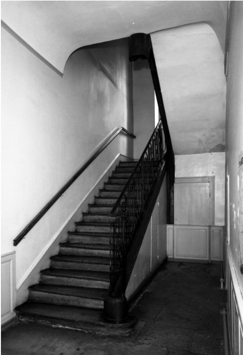
Escalier, première volée.
