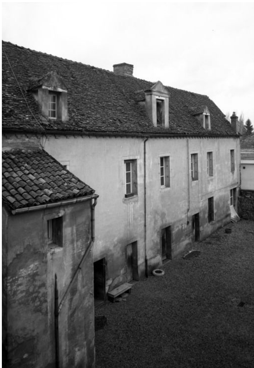
Ancien bâtiment des prisons, façade sur cour.
