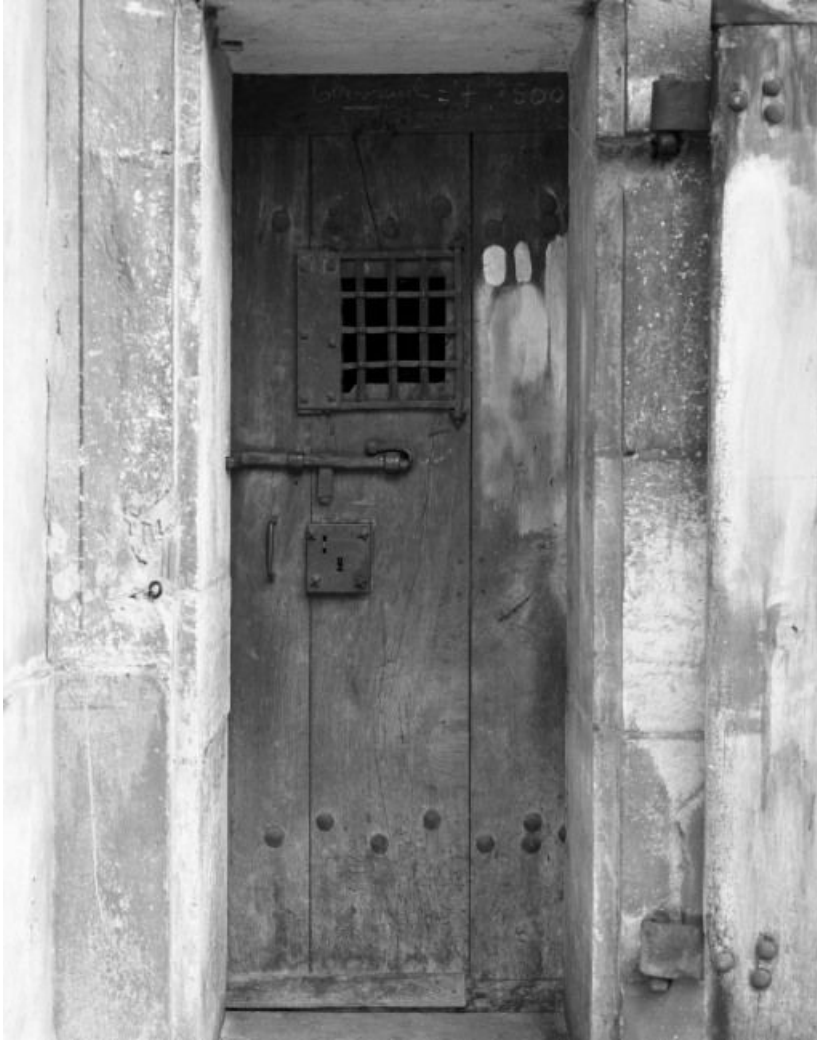
Ancien bâtiment des prisons, porte. 21, Seurre Hôtel de Ville
