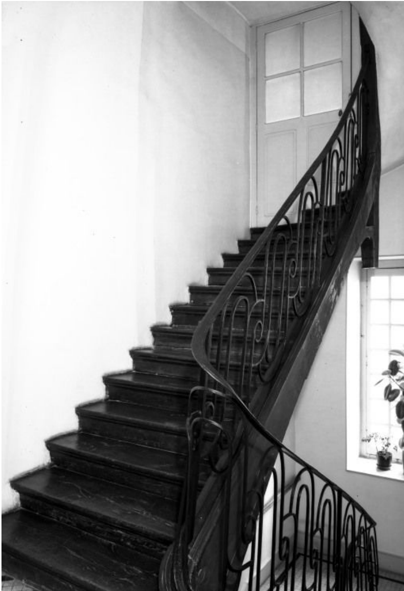
Escalier, volée menant au comble. 21, Seurre Hôtel de Ville
