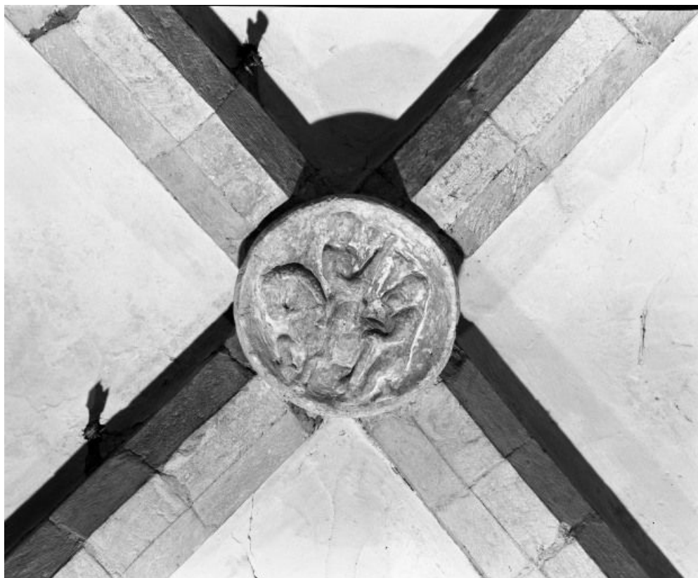
Bas-côté gauche, 2e clef de voûte 21, Seurre rue des Ecoles
