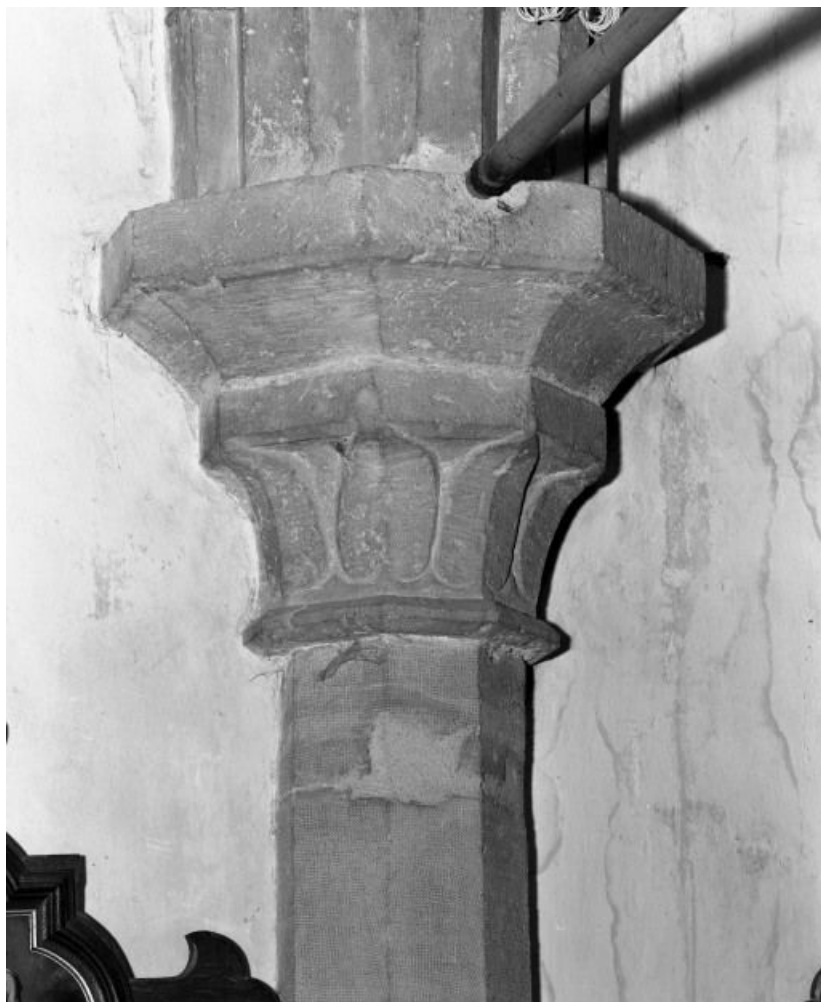
Bas-côté droit, 2e travée, chapiteau du pilier postérieur droit 21, Seurre rue des Ecoles
