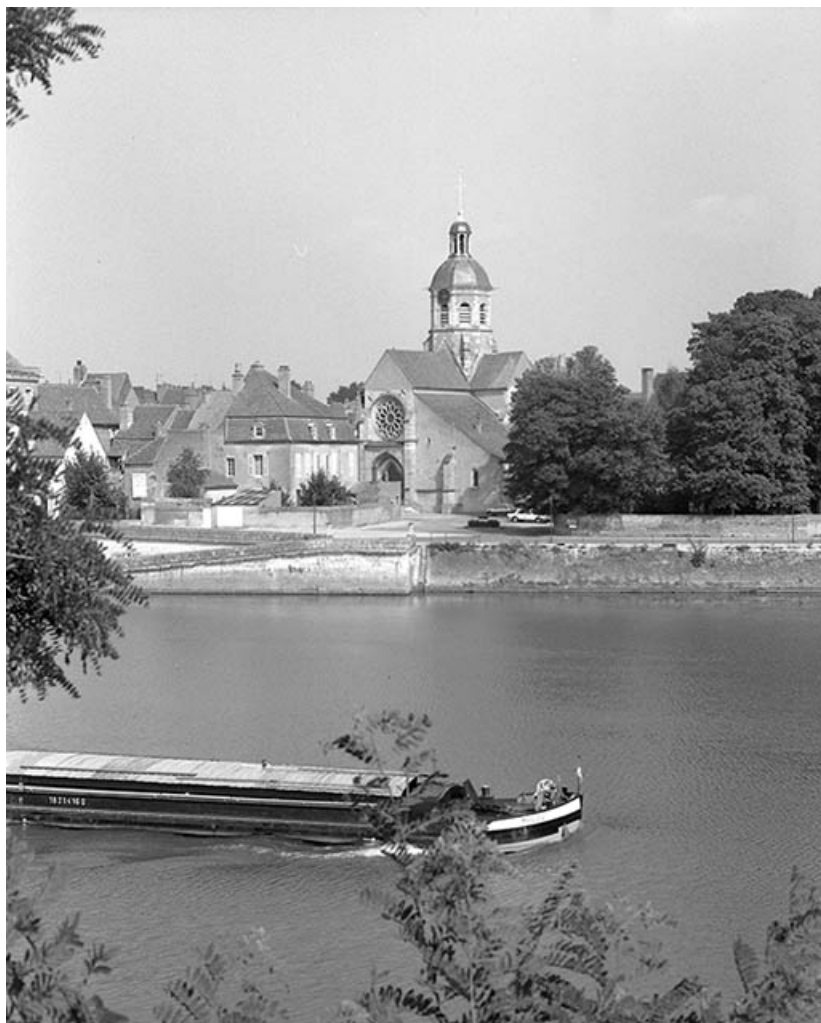
Vue générale prise du sud-ouest.
