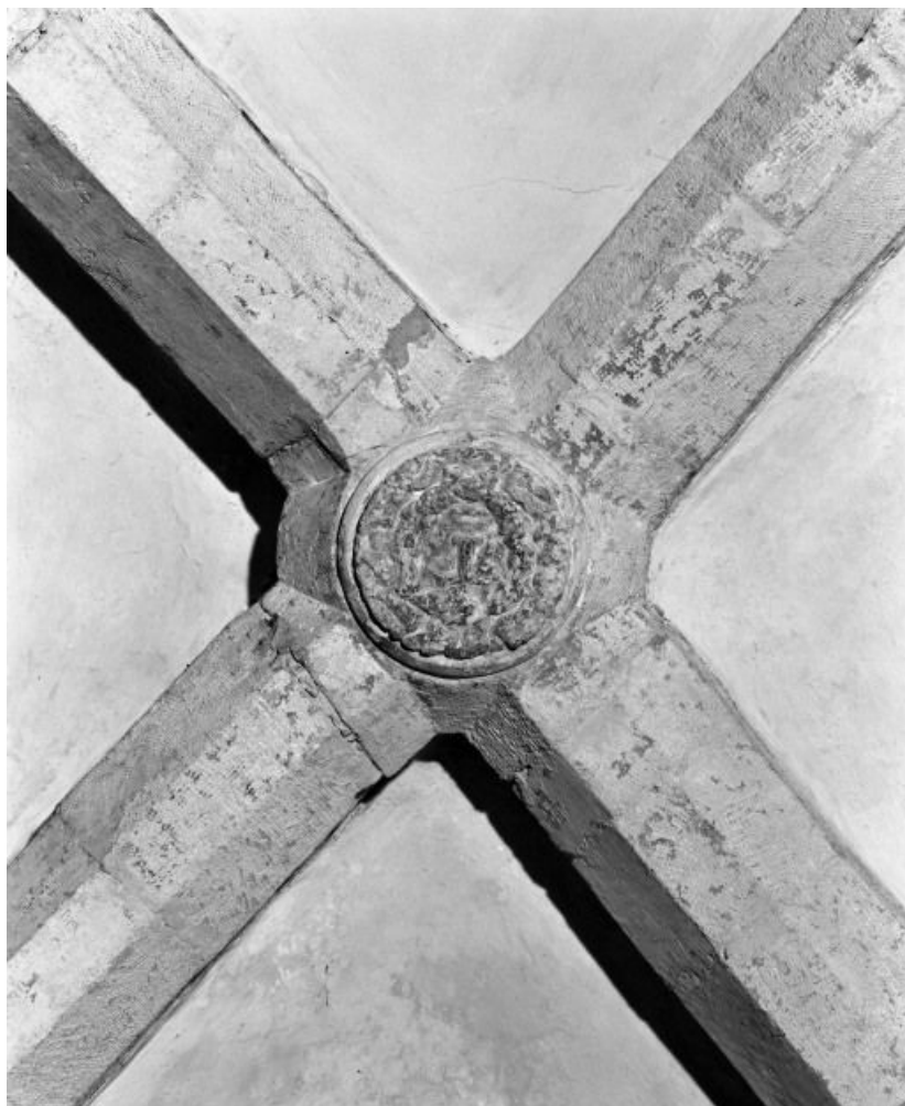
Bas-côté droit, 2e clef de voûte 21, Seurre rue des Ecoles
