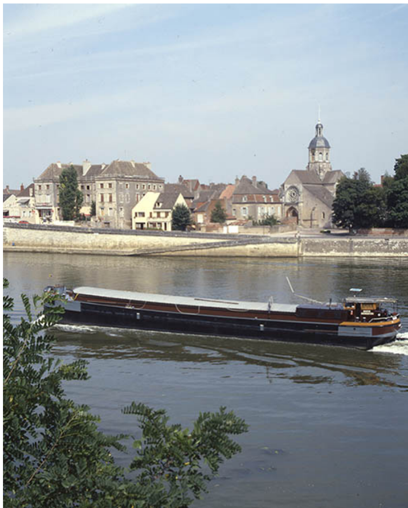
Vue générale prise du sud-ouest.
