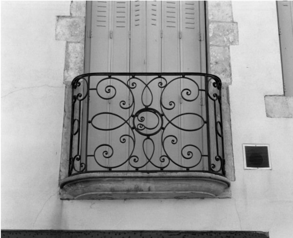
Détail : grille de balcon.
