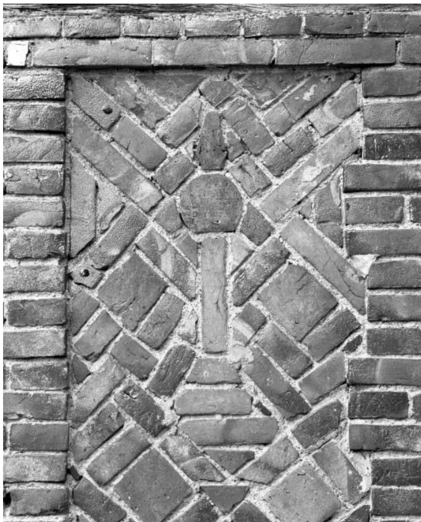
Détail (au rez-de-chaussée, à gauche). 21, Pouilly-sur-Saône Eglise
