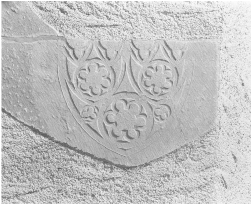
Élévation droite, linteau de la porte murée du chœur
