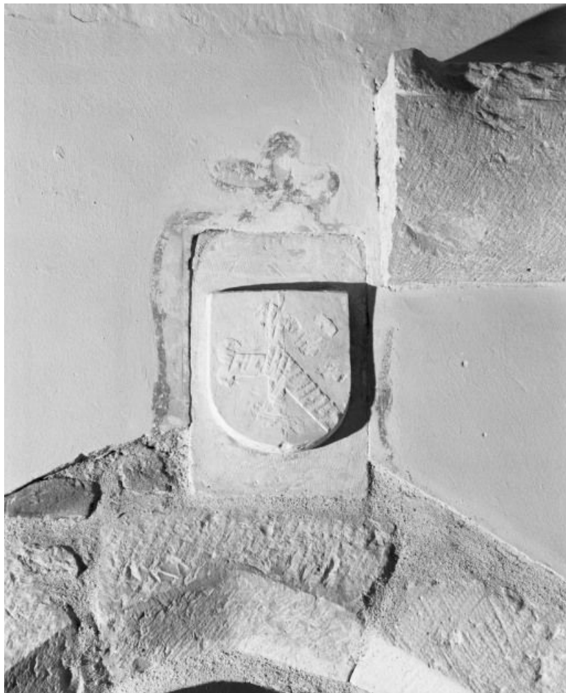
Choeur, mur gauche, blason de la chapelle seigneuriale 21, Pouilly-sur-Saône
