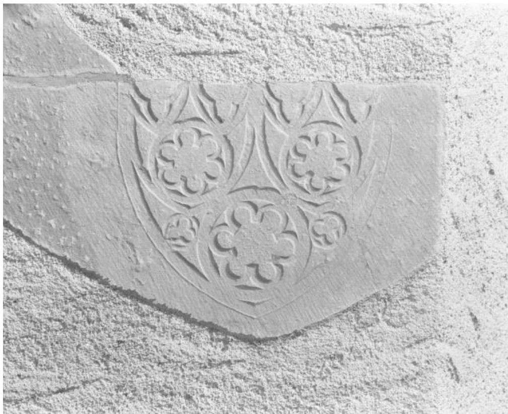
Élévation droite, linteau de la porte murée du choeur
