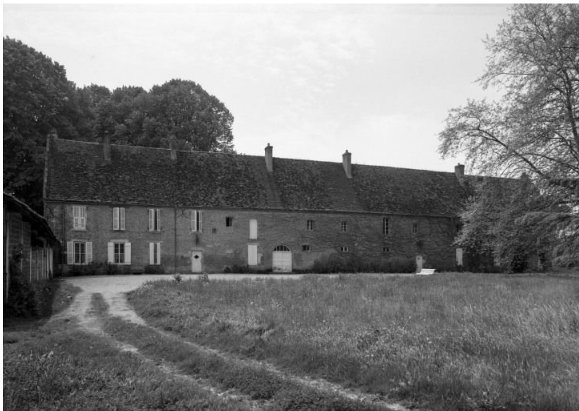
Bâtiment de l'ancien château, élévation sur cour.
