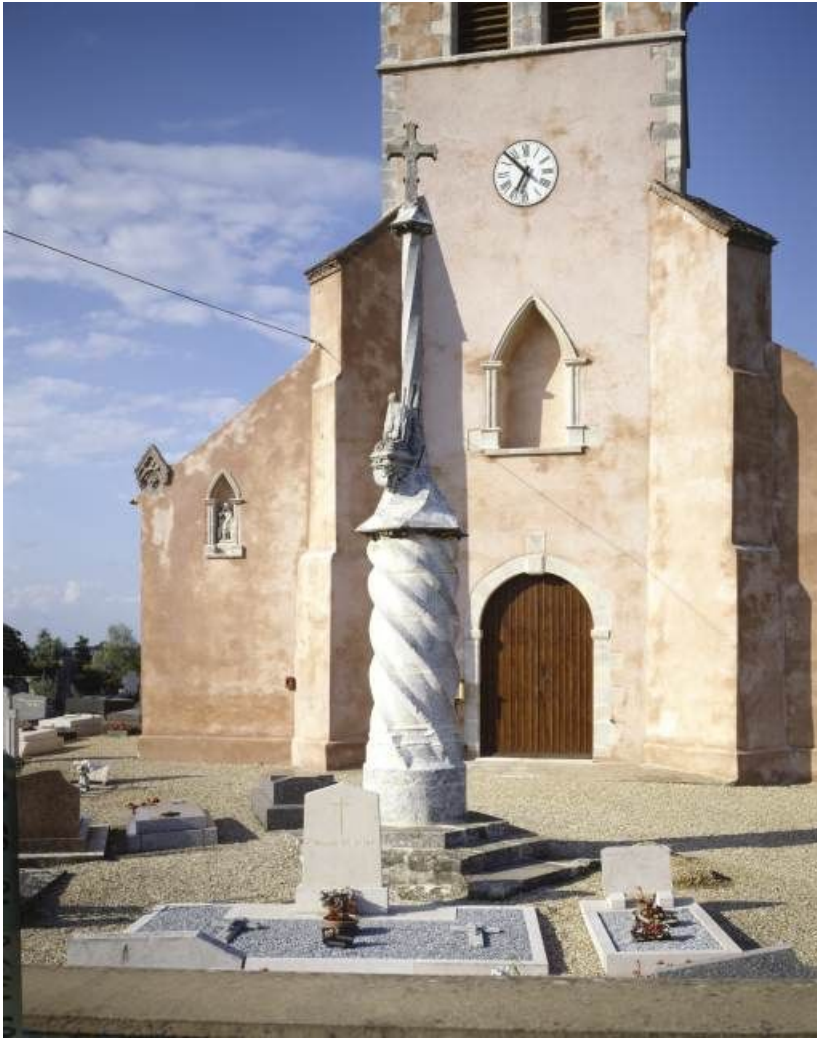
Vue d'ensemble côté sud.
