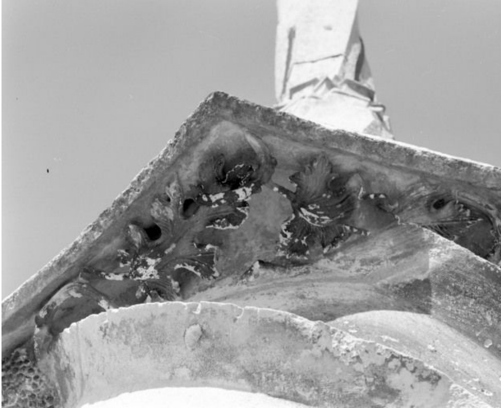
Frise du piédestal, détail. 21, Pagny-la-Ville Eglise
