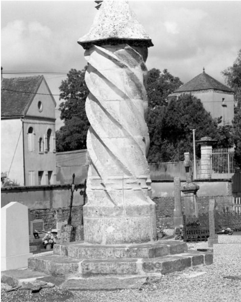
Détail de la base et du fût.
