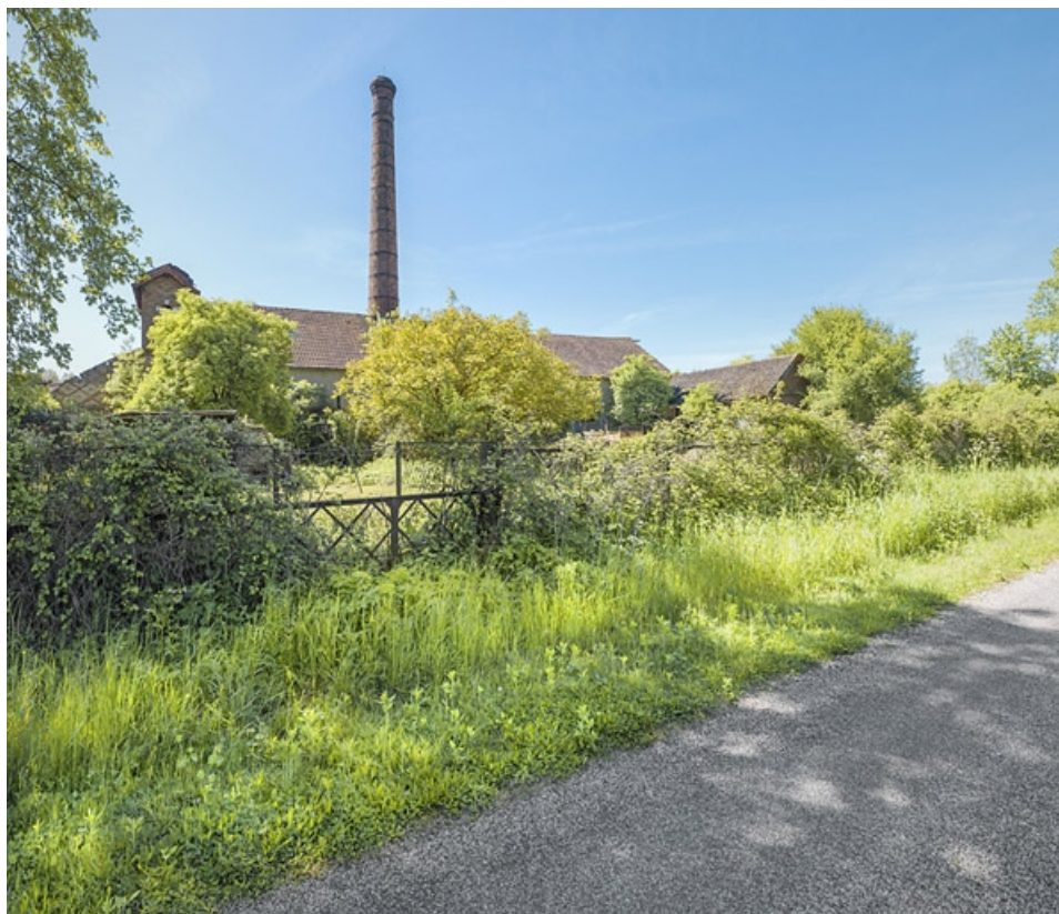
Vue d'ensemble des bâtiments de l'ancienne féculerie avec la cheminée.
