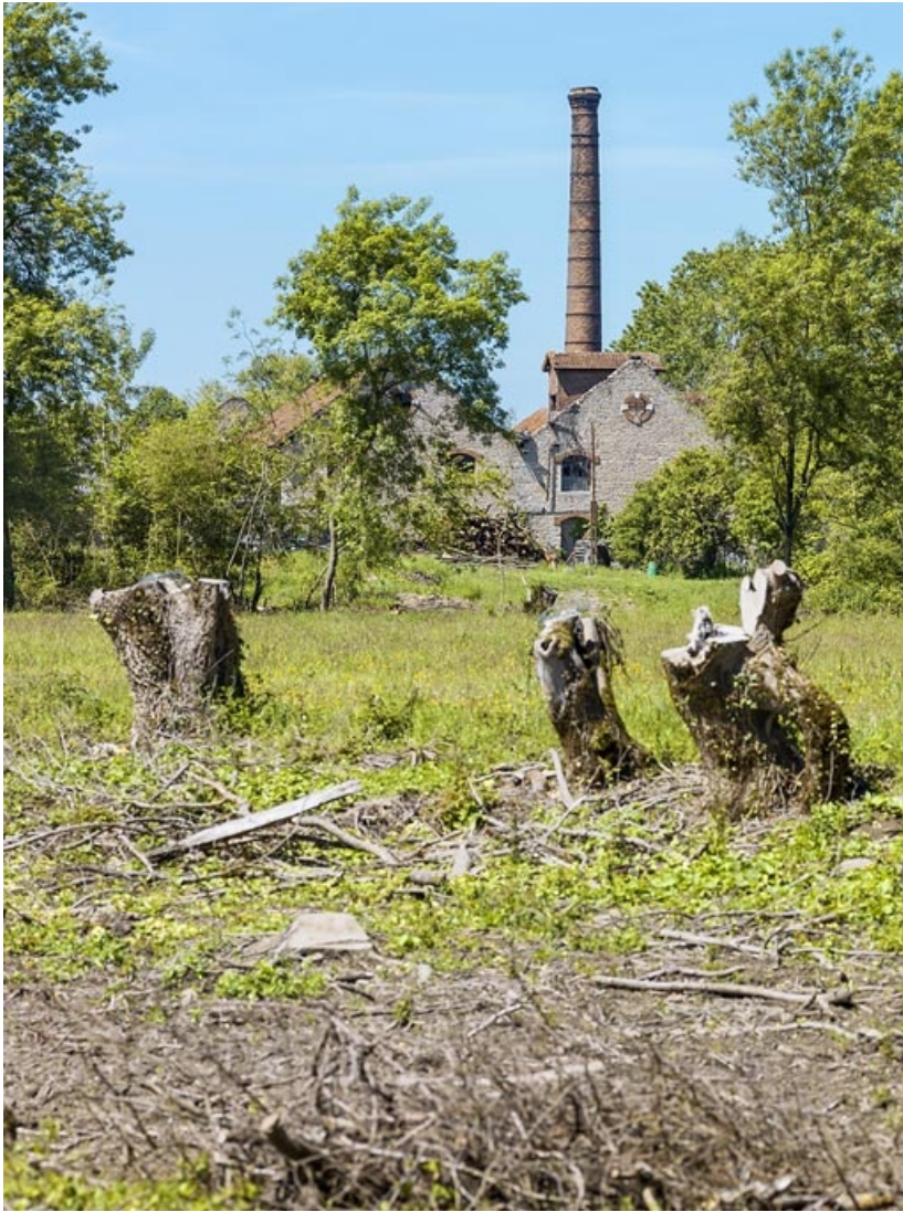
Vue d'ensemble des bâtiments de l'ancienne féculerie avec la cheminée. 21, Pagny-la-Ville Toutenant
