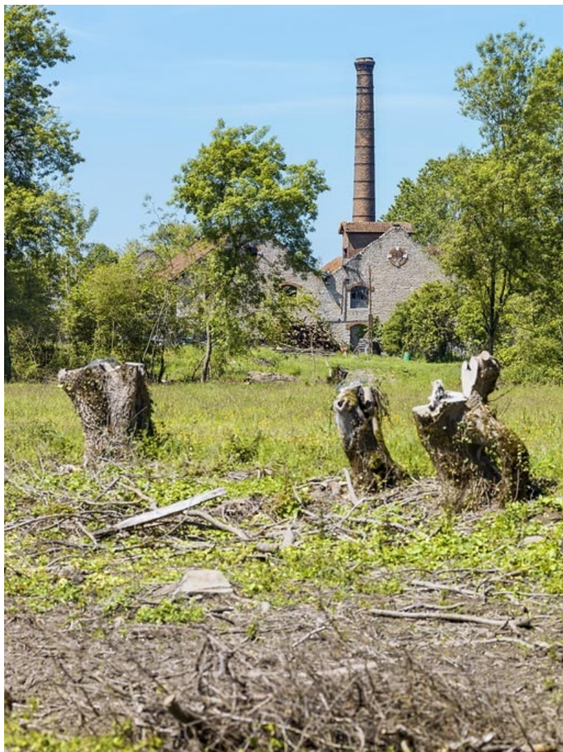
Vue d'ensemble des bâtiments de l'ancienne féculerie avec la cheminée. 21, Pagny-la-Ville Toutenant
