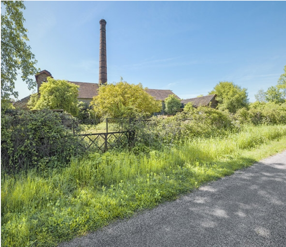
Vue d'ensemble des bâtiments de l'ancienne féculerie avec la cheminée. 21, Pagny-la-Ville Toutenant
