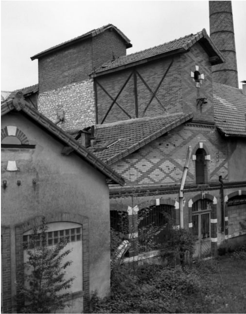
Bâtiments donnant sur la Saône, vue prise de la rampe d'accès nord. 21, Pagny-la-Ville Toutenant
