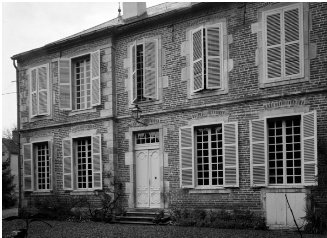
Bâtiment principal, élévation antérieure.
