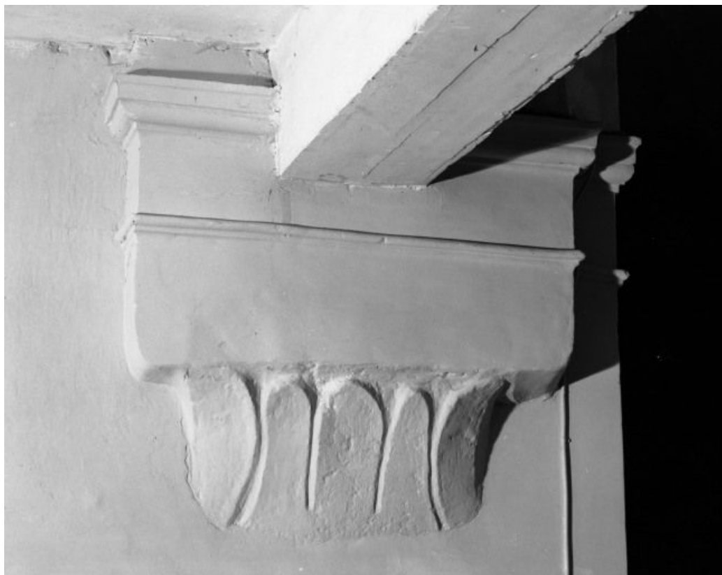
Nef, mur antérieur, pilastre droit 21, Pagny-la-Ville
