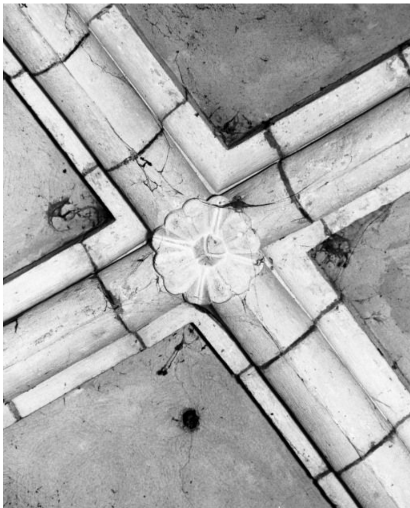
Choeur, 1ère travée, clef de voûte
