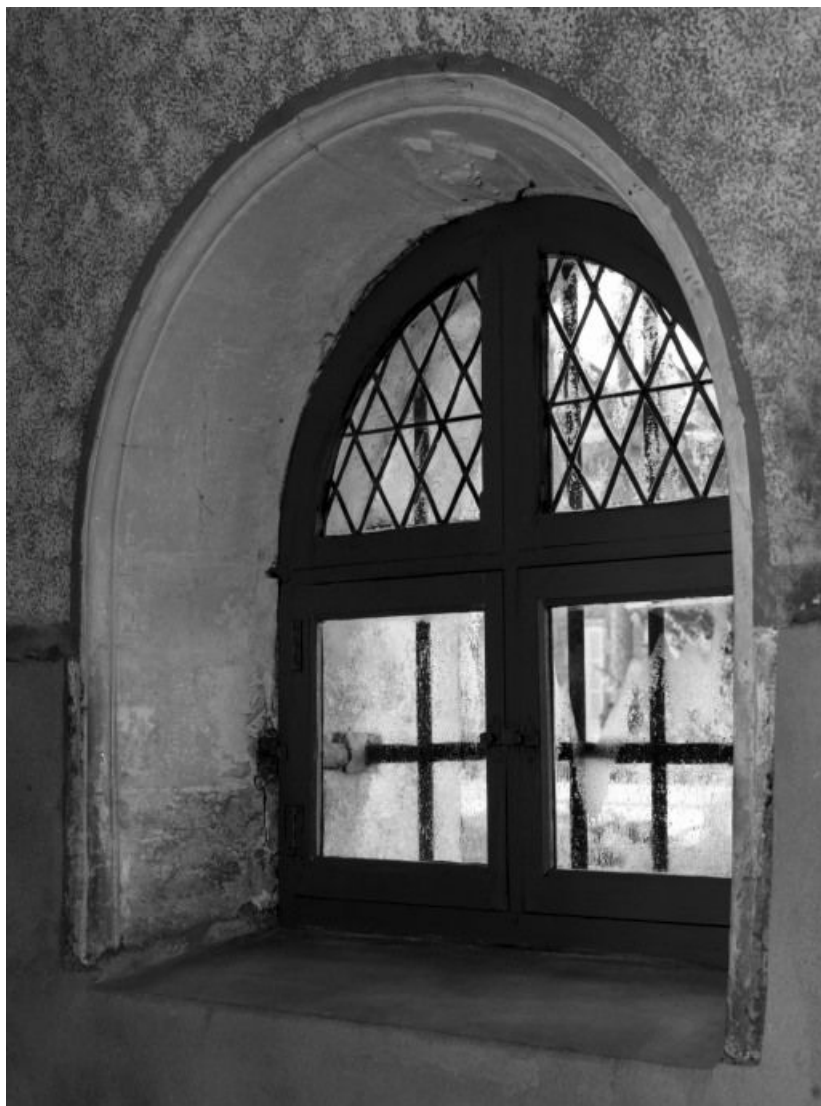
Sacristie, mur gauche, fenêtre
