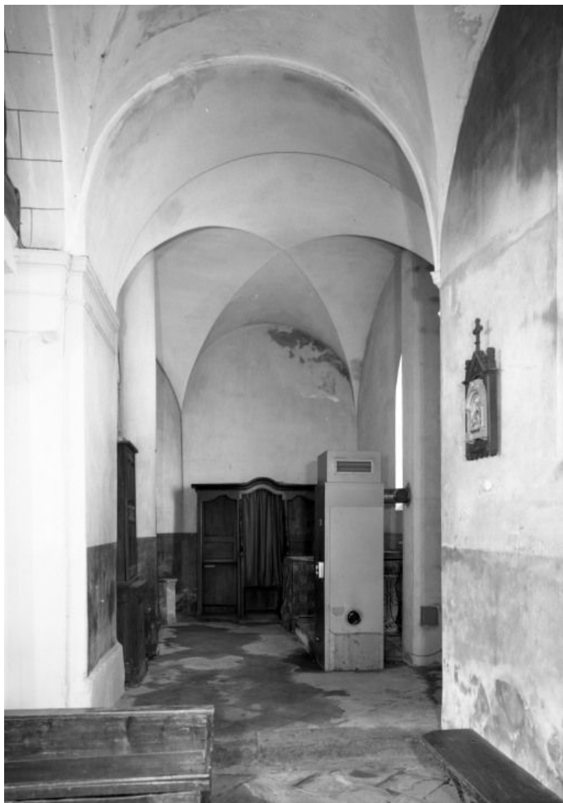
Pièce à droite du vestibule
