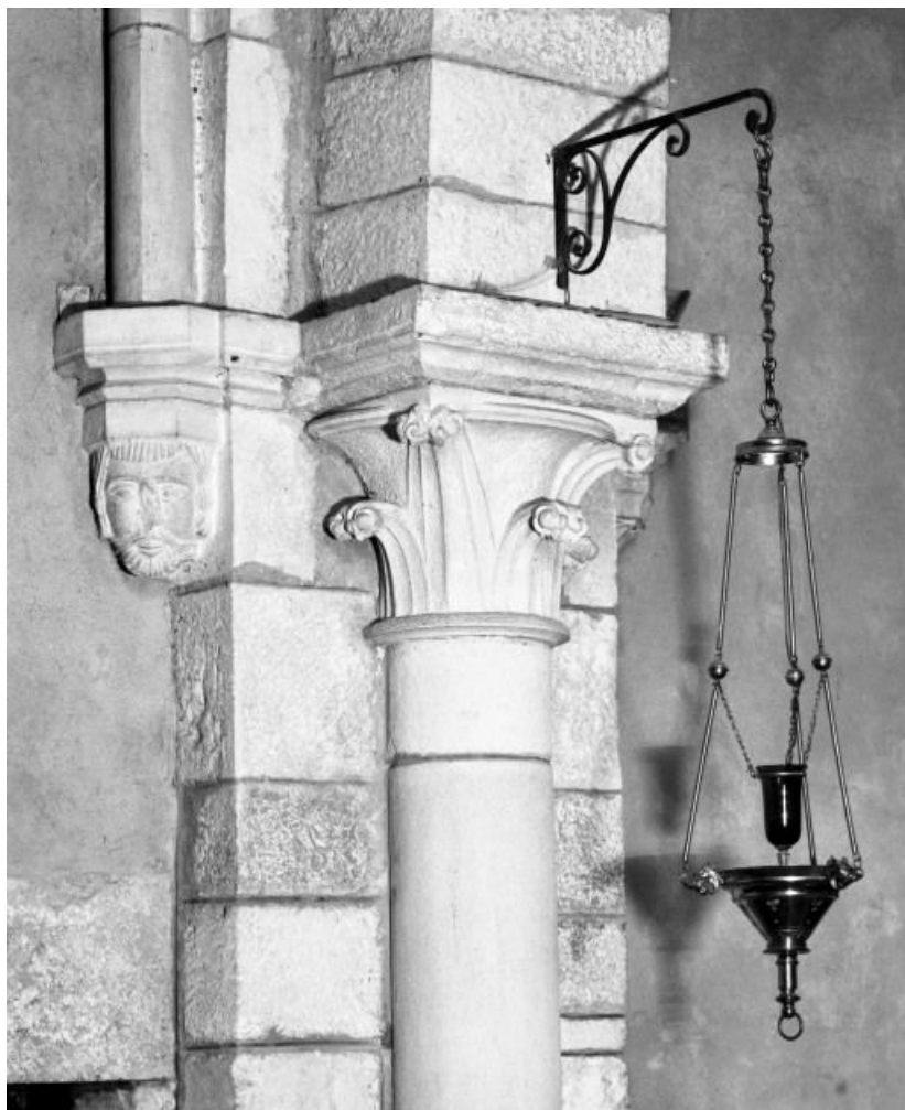
Choeur, chapiteau de la 2e colonne gauche 21, Pagny-la-Ville
