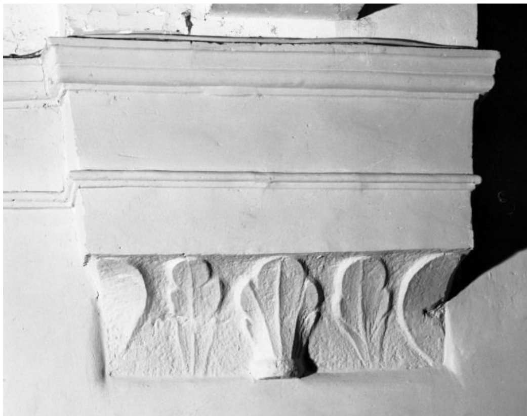
Nef, mur antérieur, pilastre gauche 21, Pagny-la-Ville
