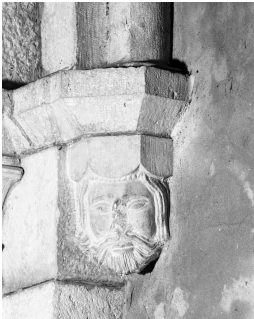
Choeur, 1ère travée, culot postérieur gauche 21, Pagny-la-Ville
