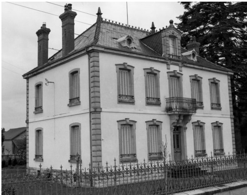
Vue d'ensemble. 21, Pagny-la-Ville
