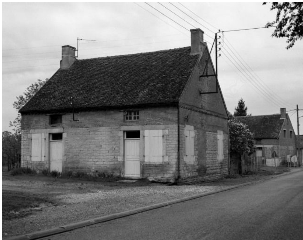
Vue d'ensemble. 21, Pagny-la-Ville
