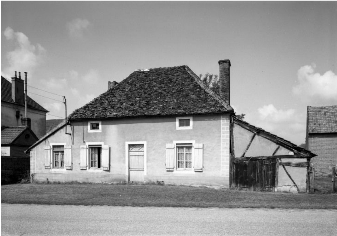
Logis, élévation antérieure.
