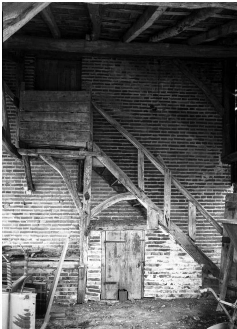
Détail : escalier en bois.
