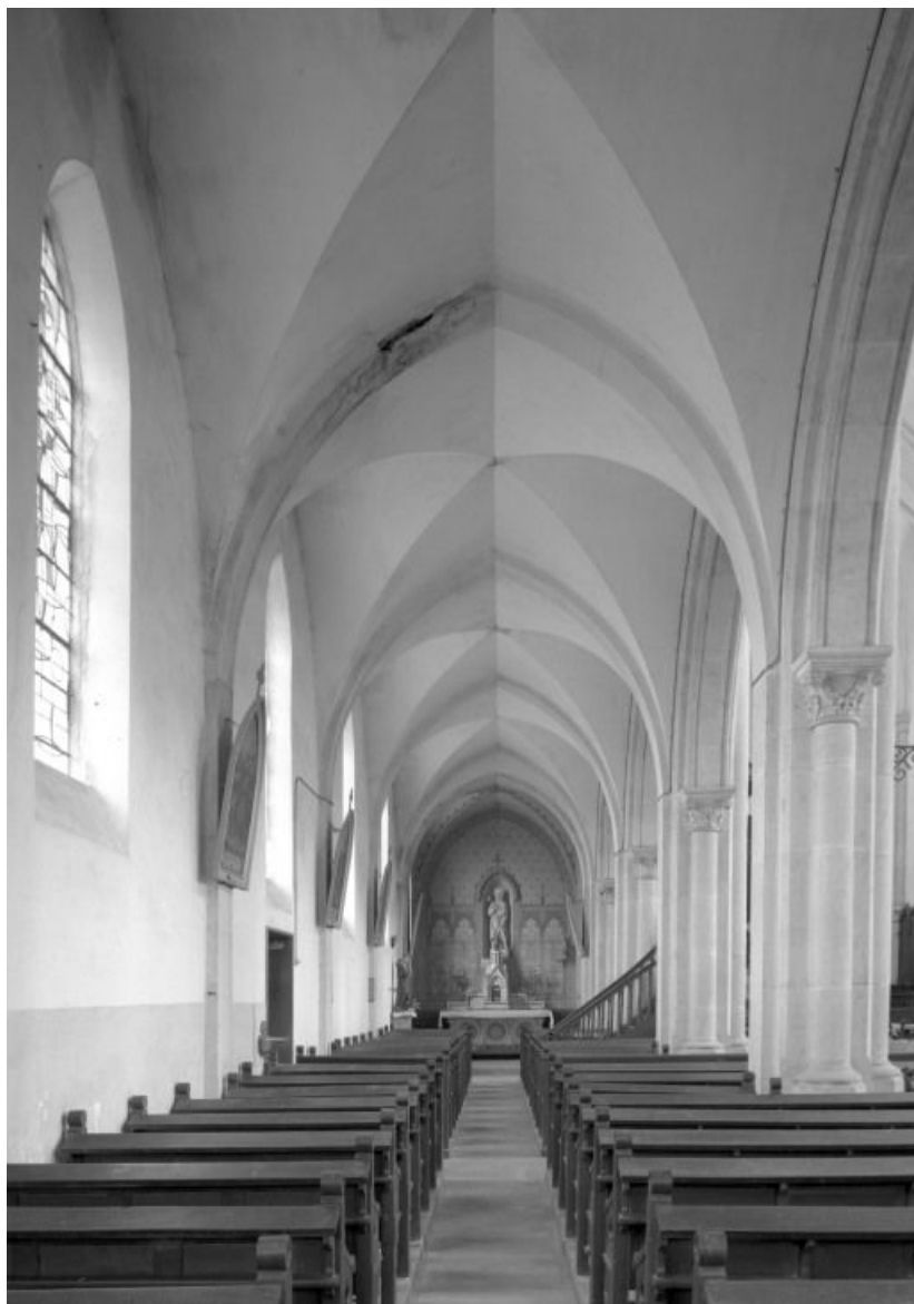
Collatéral gauche, vue prise depuis l'entrée
