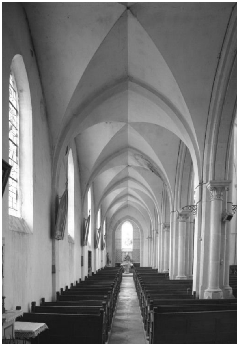
Collatéral droit, vue prise depuis l'entrée
