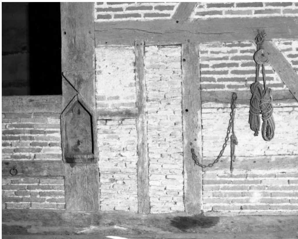
Détail intérieur du mur droit de la grange.
