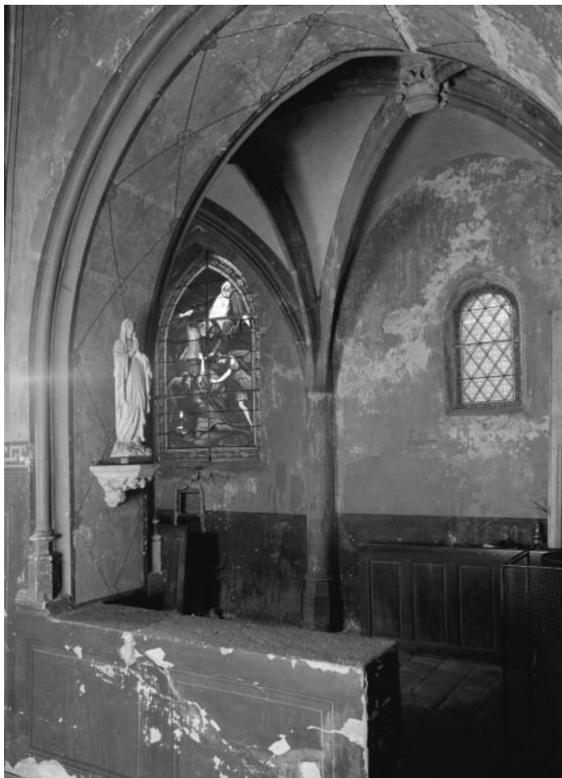
Chapelle latérale, première travée 21, Corgengoux
