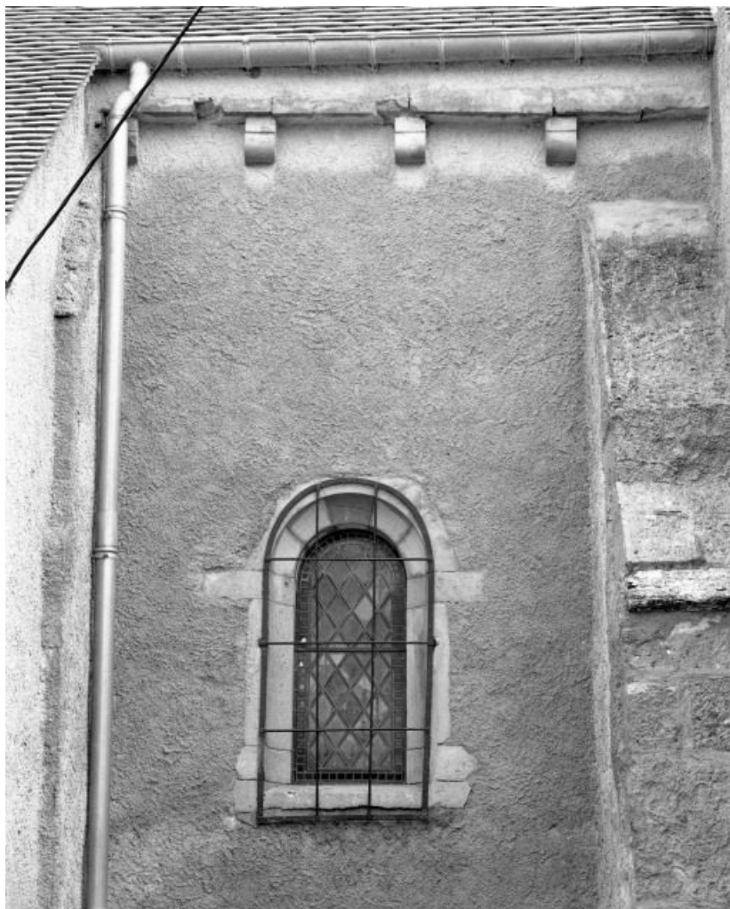
Élévation gauche, fenêtre et corniche du choeur 21, Corgengoux
