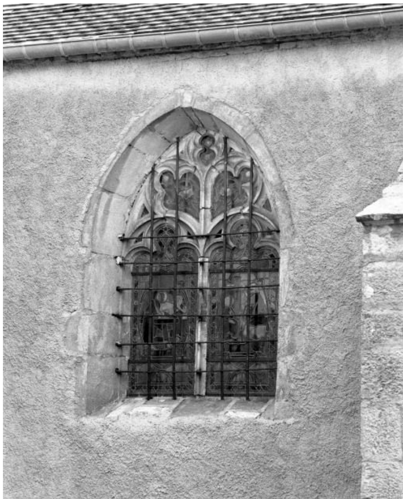
Élévation gauche, deuxième fenêtre de la nef
