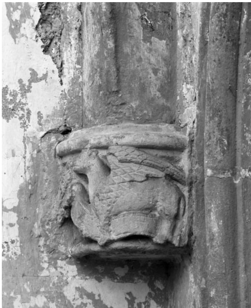
Chapelle latérale, culot antérieur gauche: boeuf de saint Luc 21, Corgengoux
