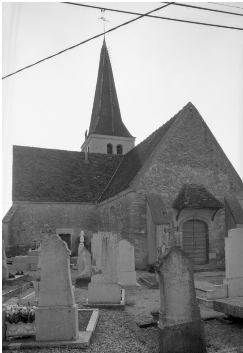
Élévation antérieure et chapelle gauche
