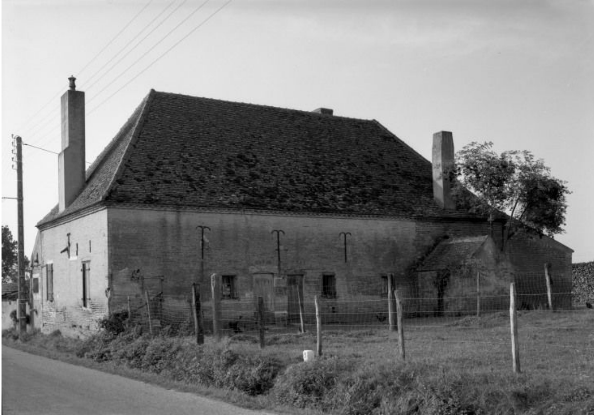
Bâtiment d'habitation, élévation postérieure.
