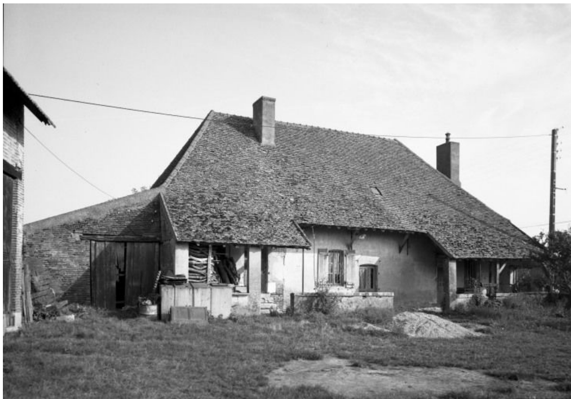
Bâtiment d'habitation, élévation antérieure.
