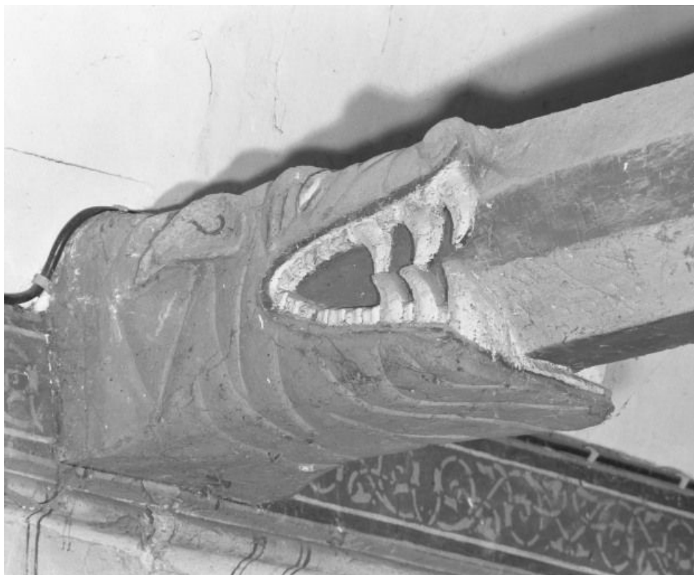
Charpente de la nef, engoulant gauche du 4ème entrain 21, Chivres grande rue
