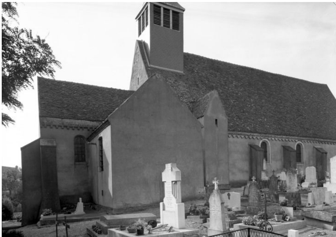
Élévation gauche, chœur et sacristie 21, Chivres grande rue
