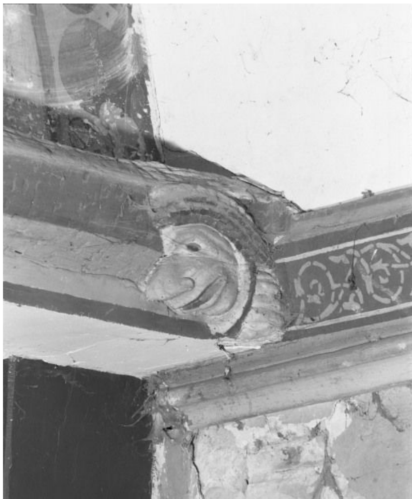
Charpente de la nef, extrémité droite du 5ème entrait 21, Chivres grande rue
