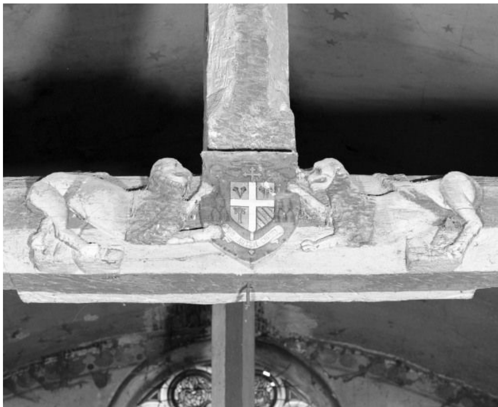
Charpente de la nef, décor du 2ème entrain (armes de Mgr Lecot, évêque de Dijon) 21, Chivres grande rue
