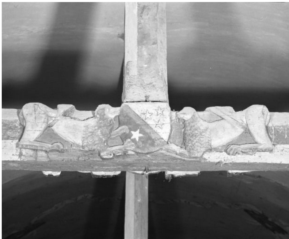
Charpente de la nef, décor du 4ème entrain 21, Chivres grande rue
