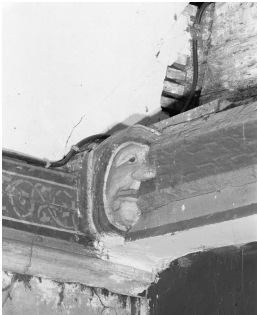
Charpente de la nef, extrémité du 5ème entrait 21, Chivres grande rue
