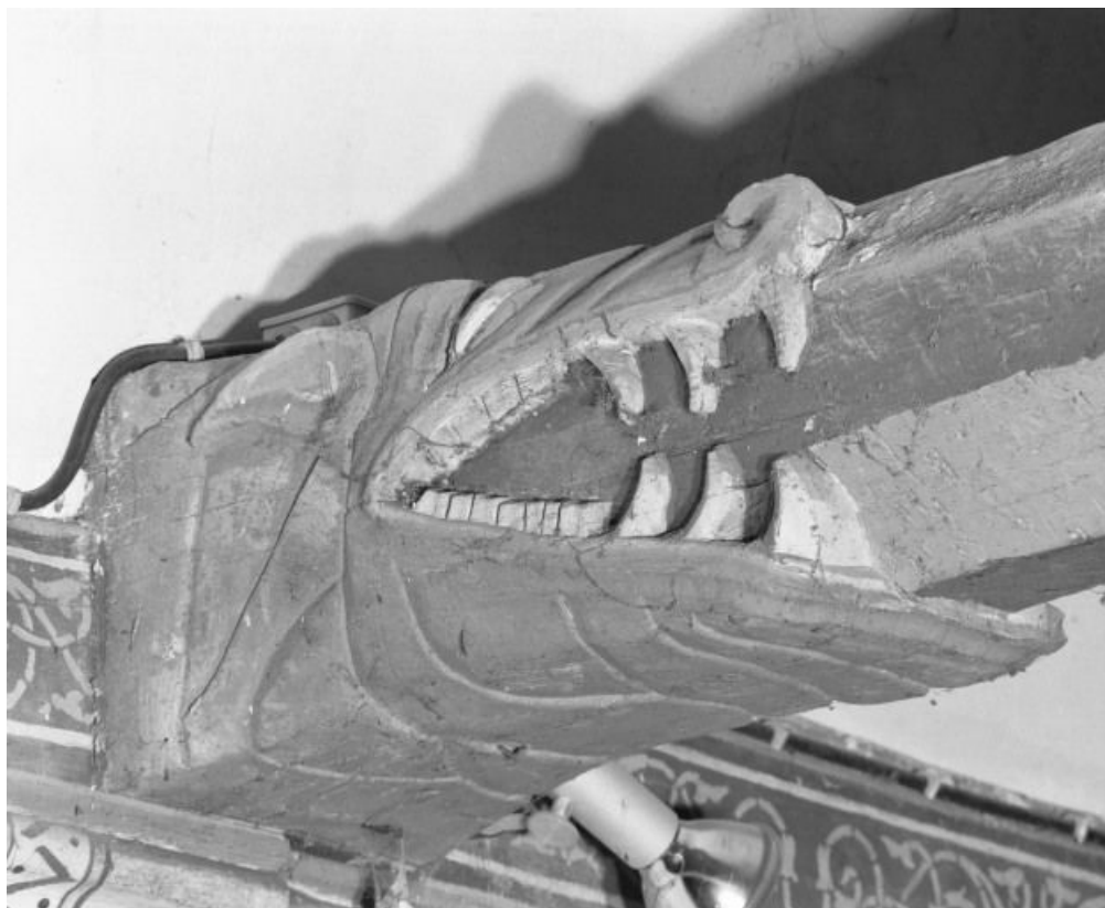
Charpente de la nef, engoulant gauche du 3ème entrain 21, Chivres grande rue
