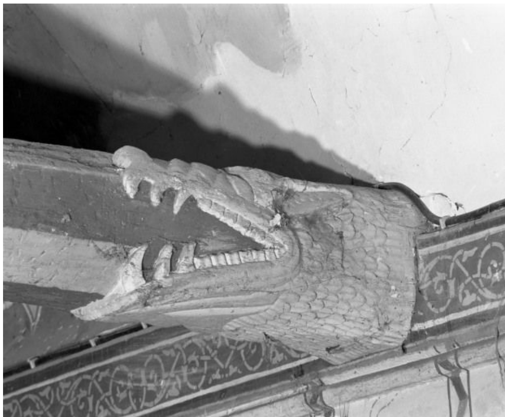
Charpente de la nef, engoulant gauche du 2ème entrain 21, Chivres grande rue
