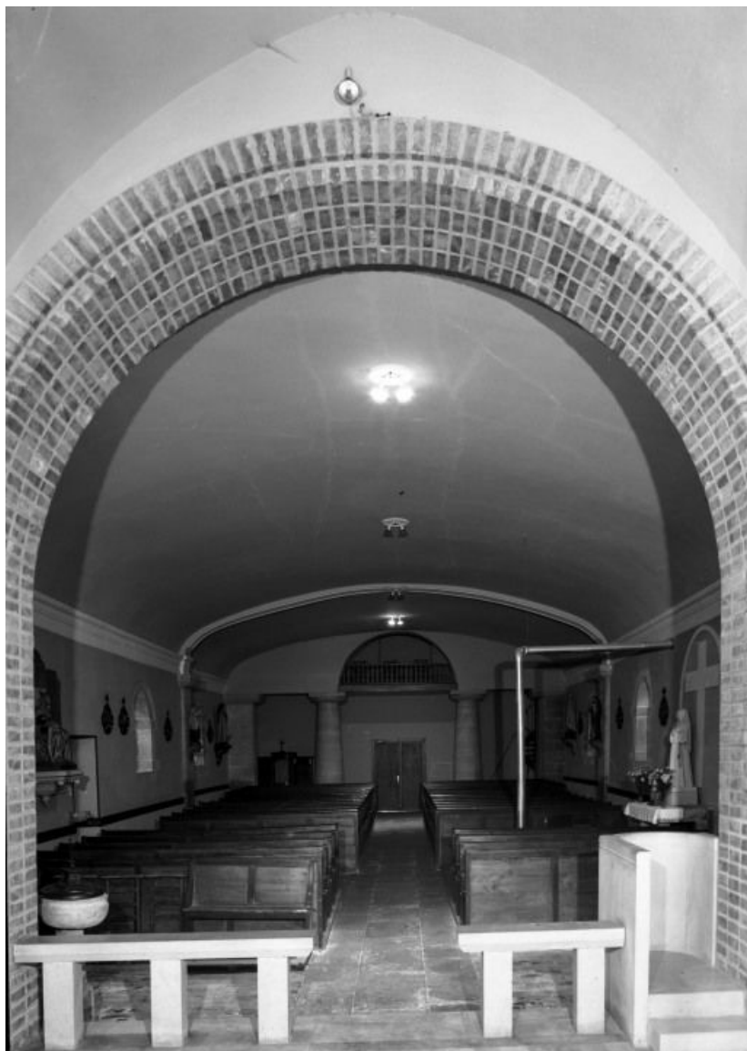
Vue de la nef prise du chœur
