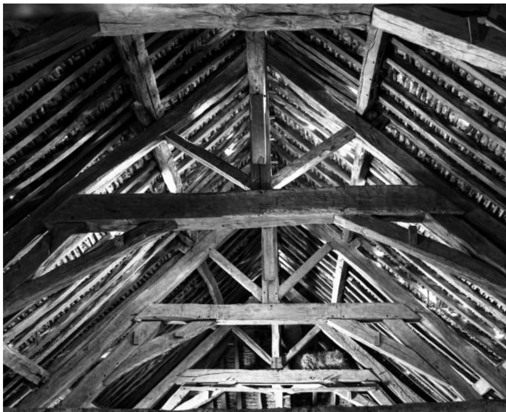
Grange, détail de la charpente.
