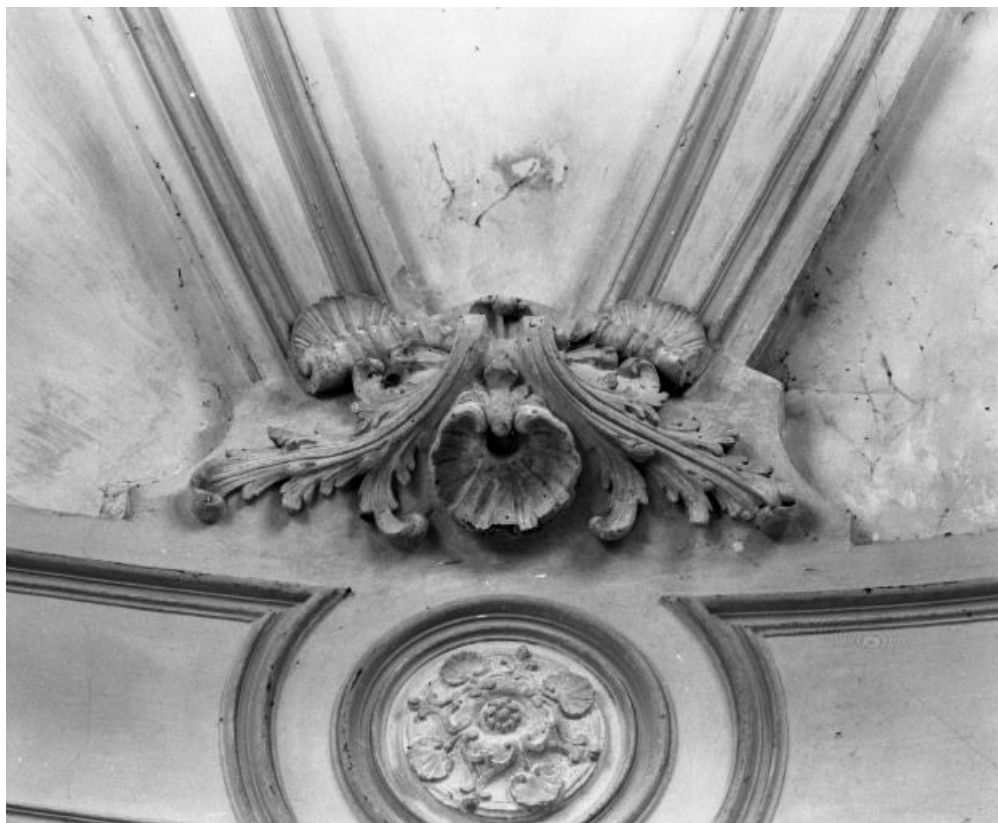
Choeur, détail de la voûte
