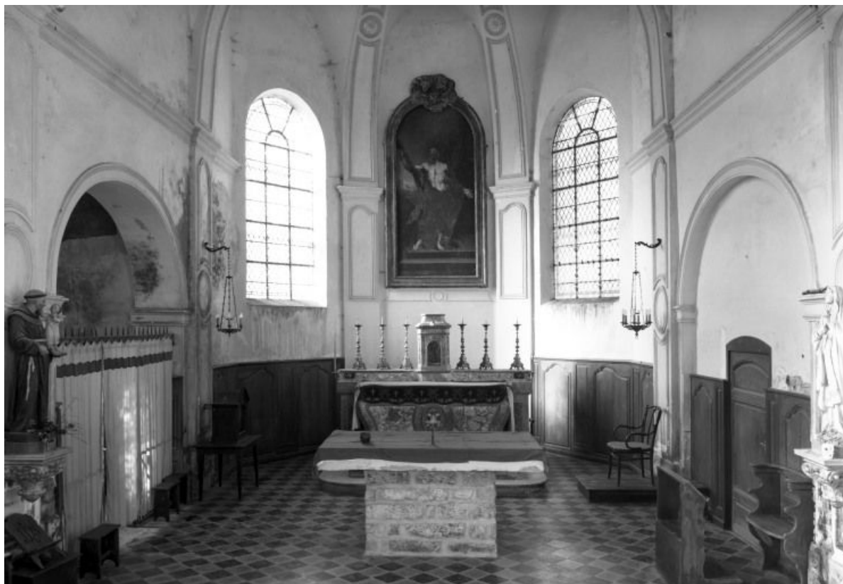
Vue intérieure du chœur 21, Broin
