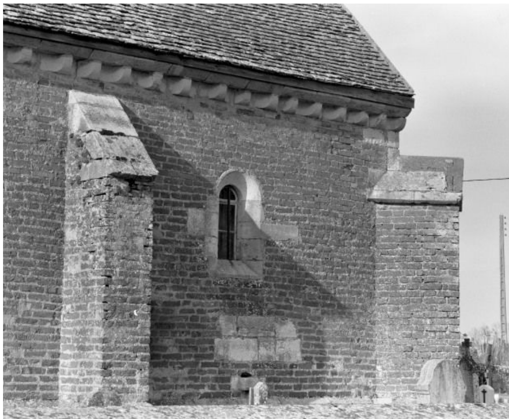
Chevet, mur droit 21, Busselange
