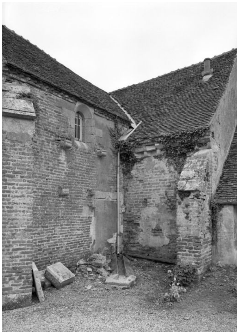
Élévation gauche, chœur et chapelle seigneuriale 21, Busselange
