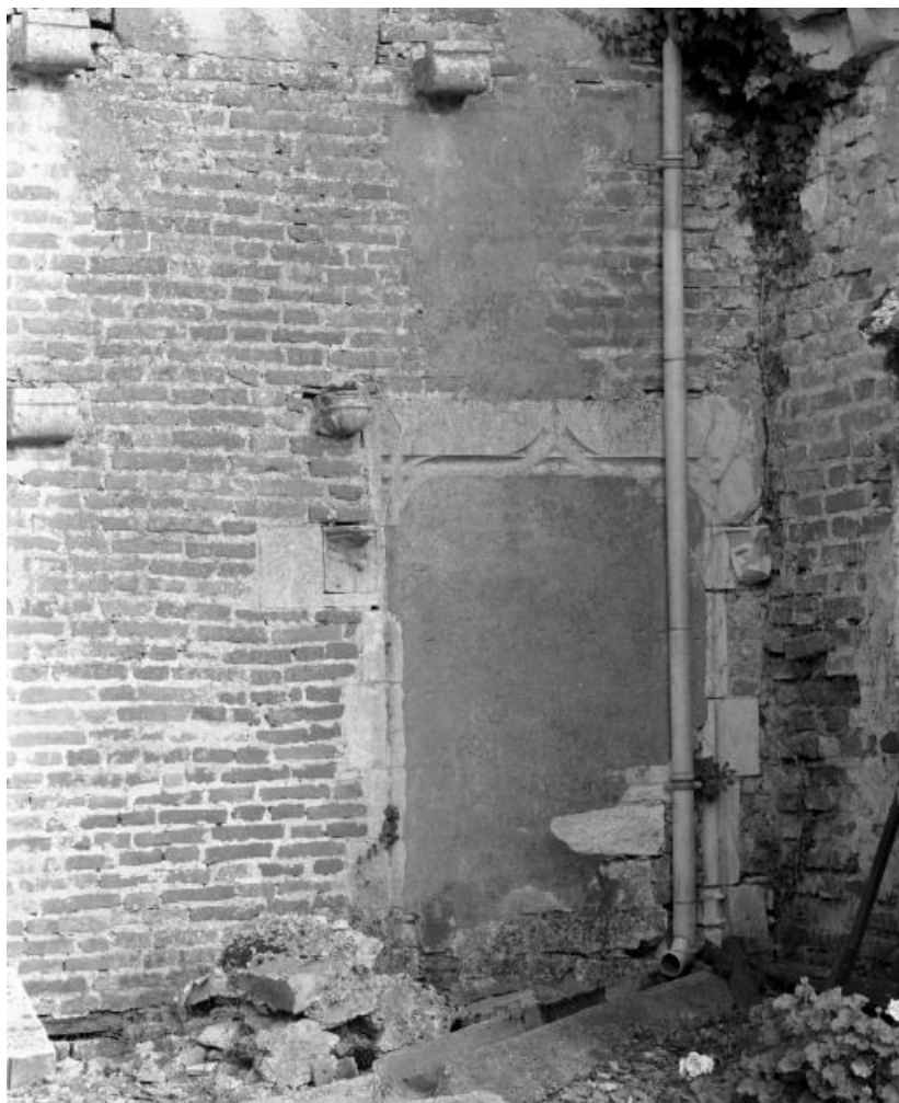
Chapelle seigneuriale, porte du mur antérieur 21, Busselange
