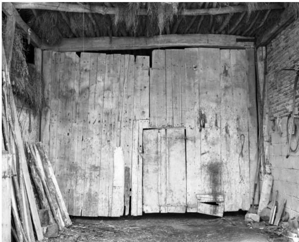
Grange, porte charretière. 21, Bonnencontre R.D. 20
