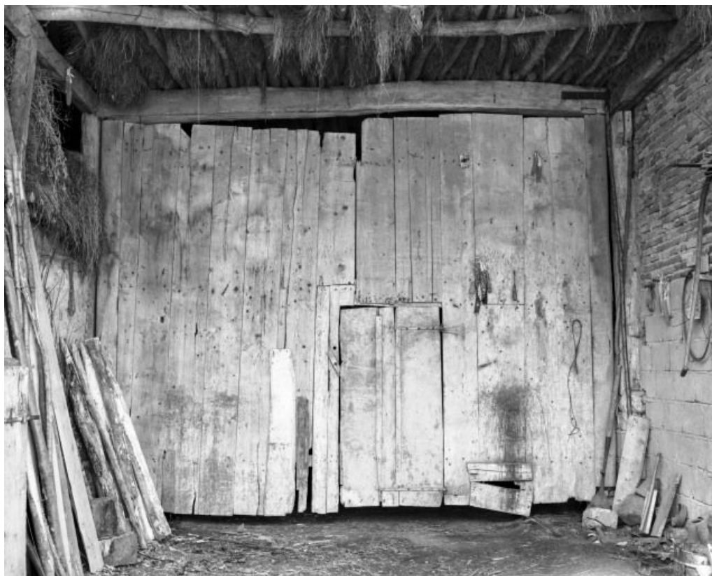
Grange, porte charretière. 21, Bonnencontre R.D. 20
