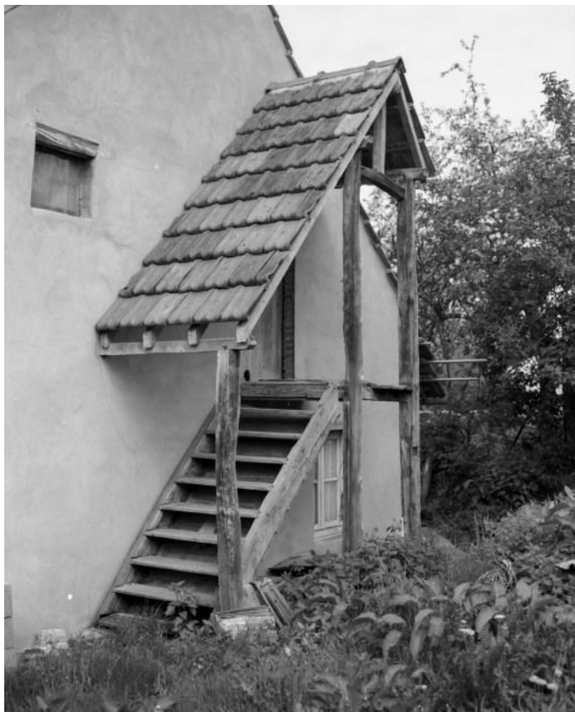
Escalier d'accès au comble.
