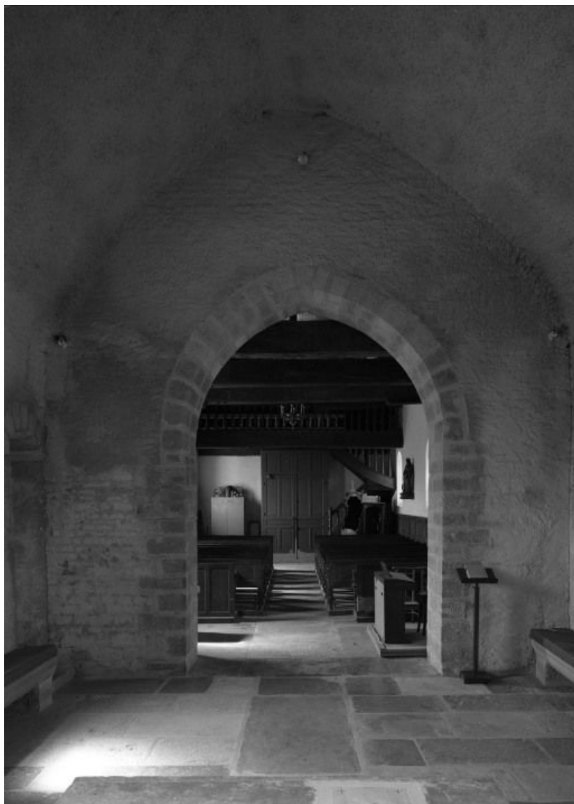
Nef et mur antérieur du chœur
